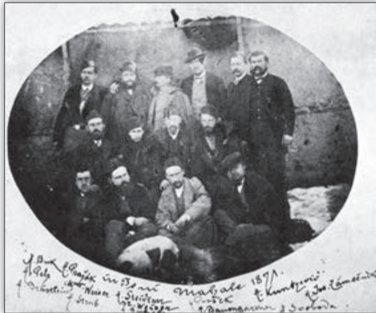
Строители на V секция на железницата „Одрин–Белово“.
