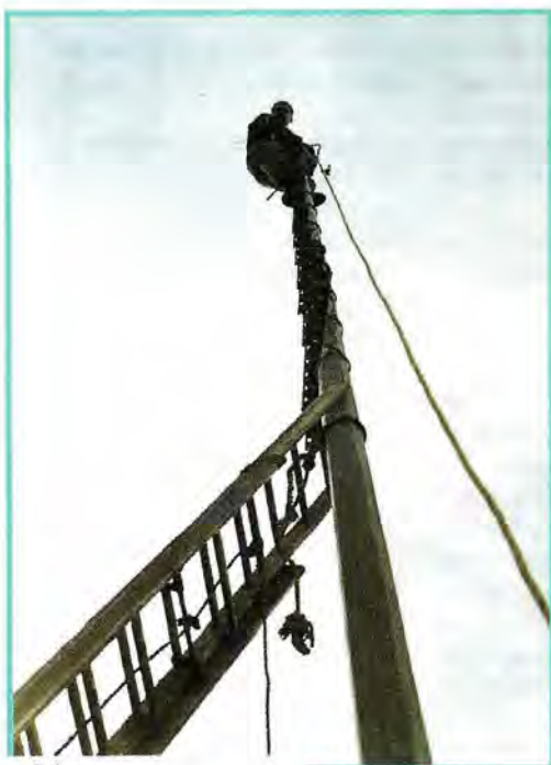
Grimper. Installer les antennes.
