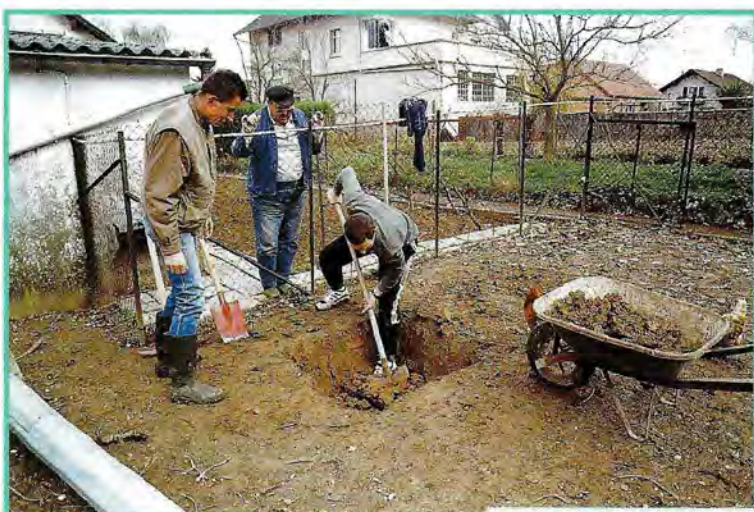
Creuser. Fondations du pylône.
