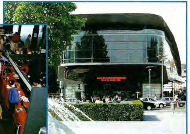
Le Vinci, belle structure au cœur de Tours.
