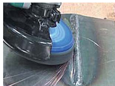
*odstraňovanie farebných defektov po zvaroch
