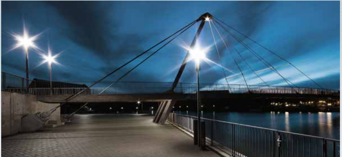
1.2 Eclairage des ponts.
