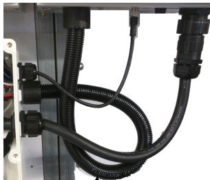
Loop the conduit
