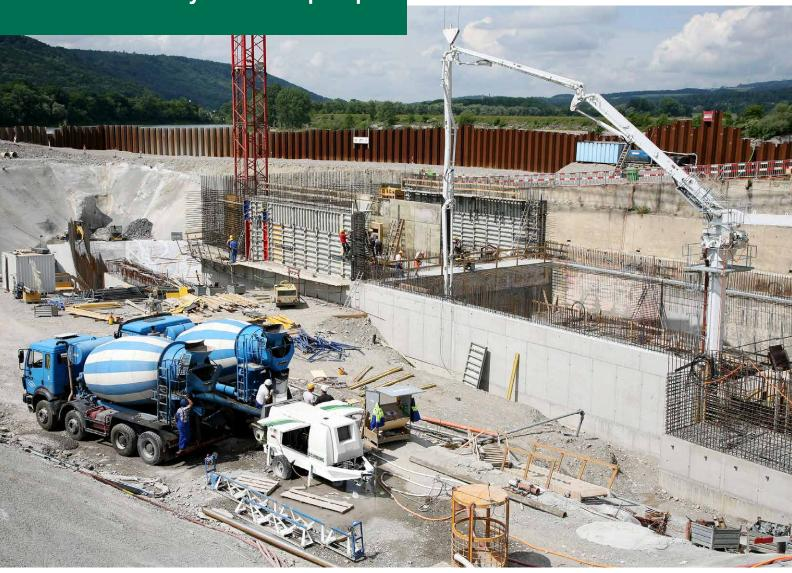
Concrete output max. 95 m³/h
