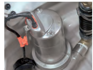
Pompe avec interrupteur à flotteur
