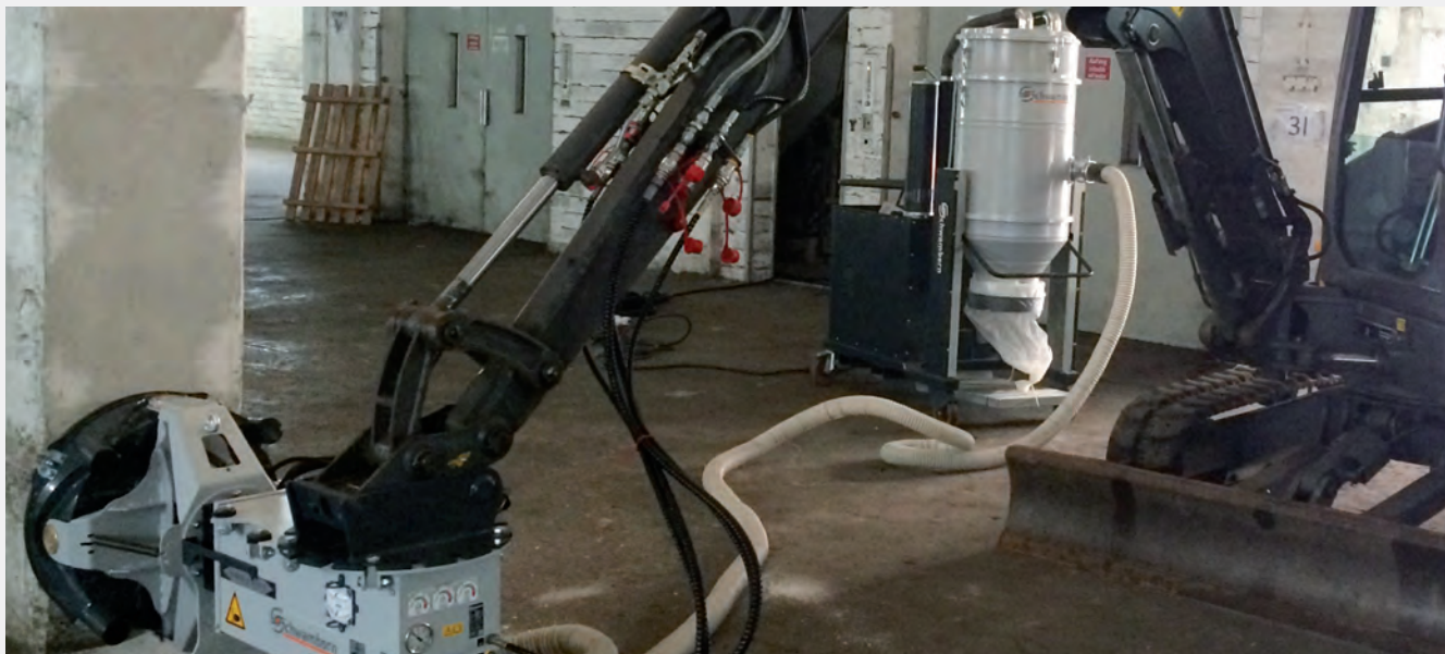
La tête de ponçage de la WDS est dotée de quatre tubulures d'aspiration, ce qui permet une aspiration multiple. Or, il s'agit là d'un véritable avantage en cas de matériau contaminé.
