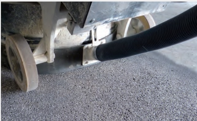
Machine pendant le bouchardage du support
