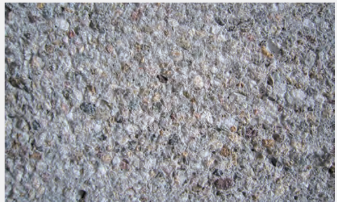
Résultat de la préparation du support par bouchardage
