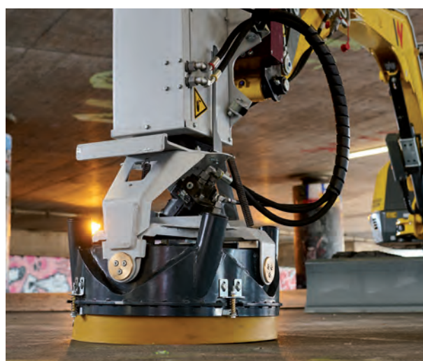
Ponçage de sols, par exemple bassins de retenue, piscines, etc.
