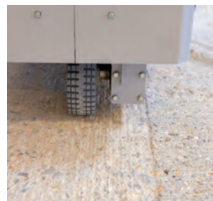
Fraisage du béton et des chapes
