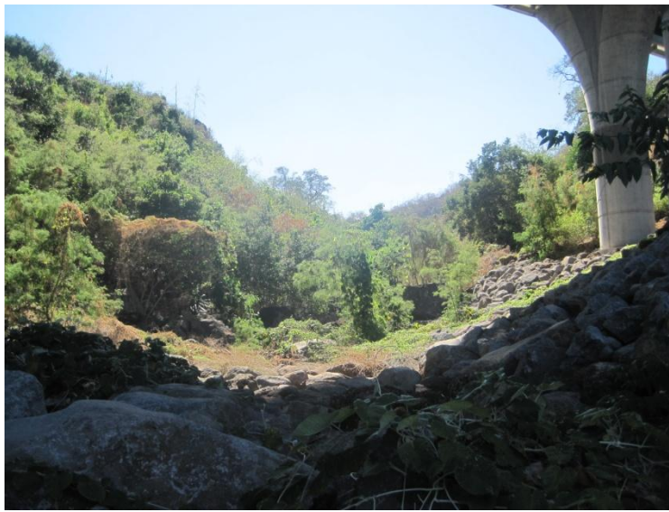
Photo2 : La ravine du Trou à l'aval de la route des Tamarins (photo prise de sous le pont)
