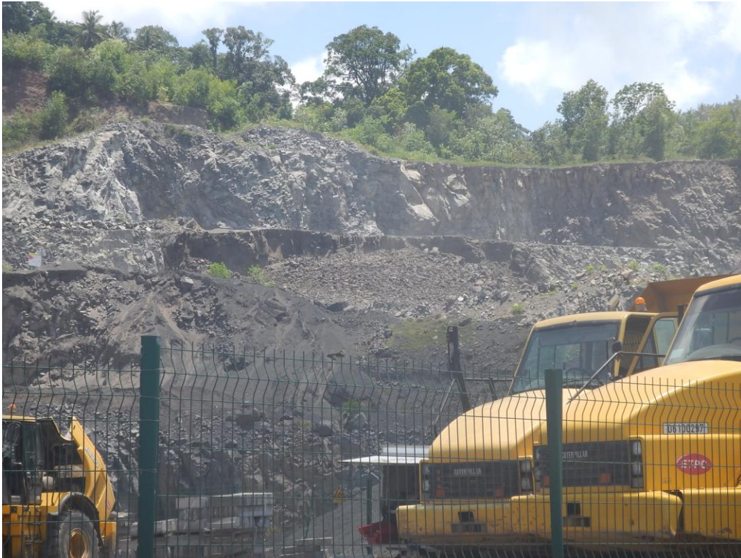
Site FFT1 - Aspect de la zone juste après le tir du 14 décembre
