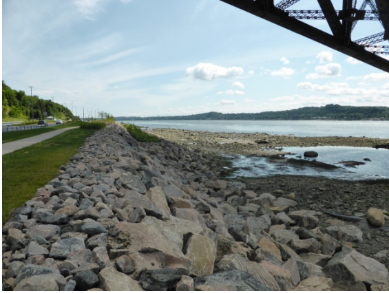
Photo 3.1 Rive du fleuve Saint-Laurent à la hauteur du pont de Québec
