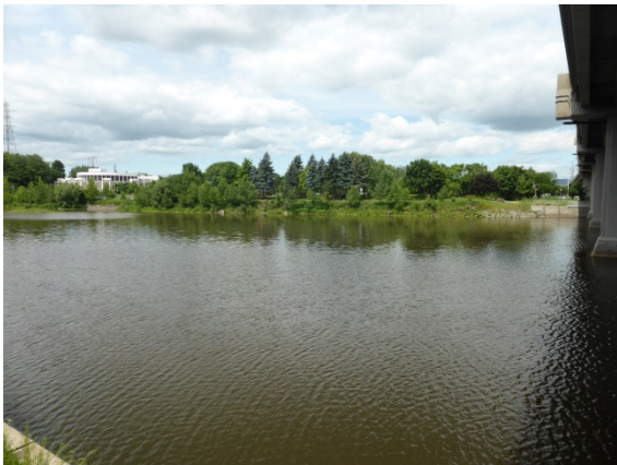
Photo 3.3 Rive-nord de la rivière Saint-Charles, à l'ouest du pont de la bretelle de l'autoroute 440 Est
