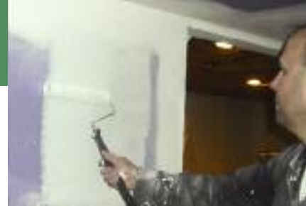
Applying primer to new drywall.
