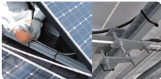
ガルバロックは、架台(ラックシステム)付近でのケーブル、配管の結束と固定のために開発されたインシュロックタイ(結束バンド)です。次のような用途でお勧めします。
