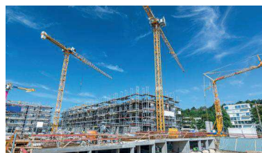
Sites de constructions temporaires
