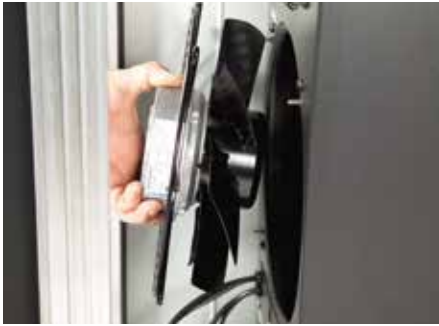
Simple fan replacement
