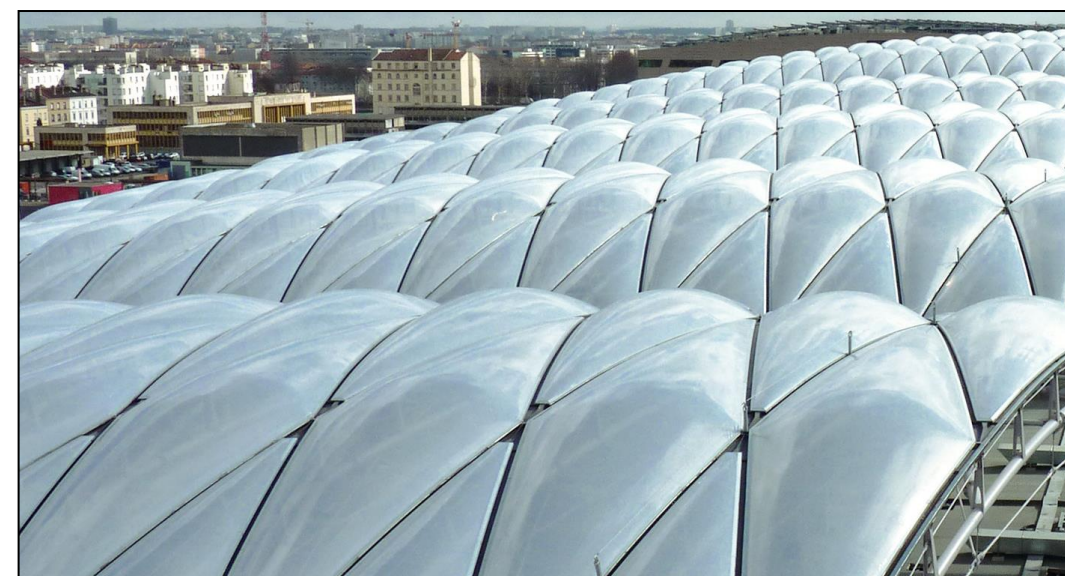
Figure 55 : Référence de façade en coussin ETFE
