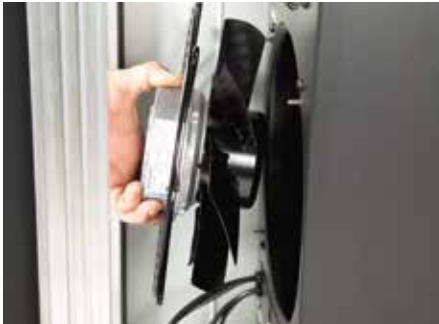
Simple fan replacement
