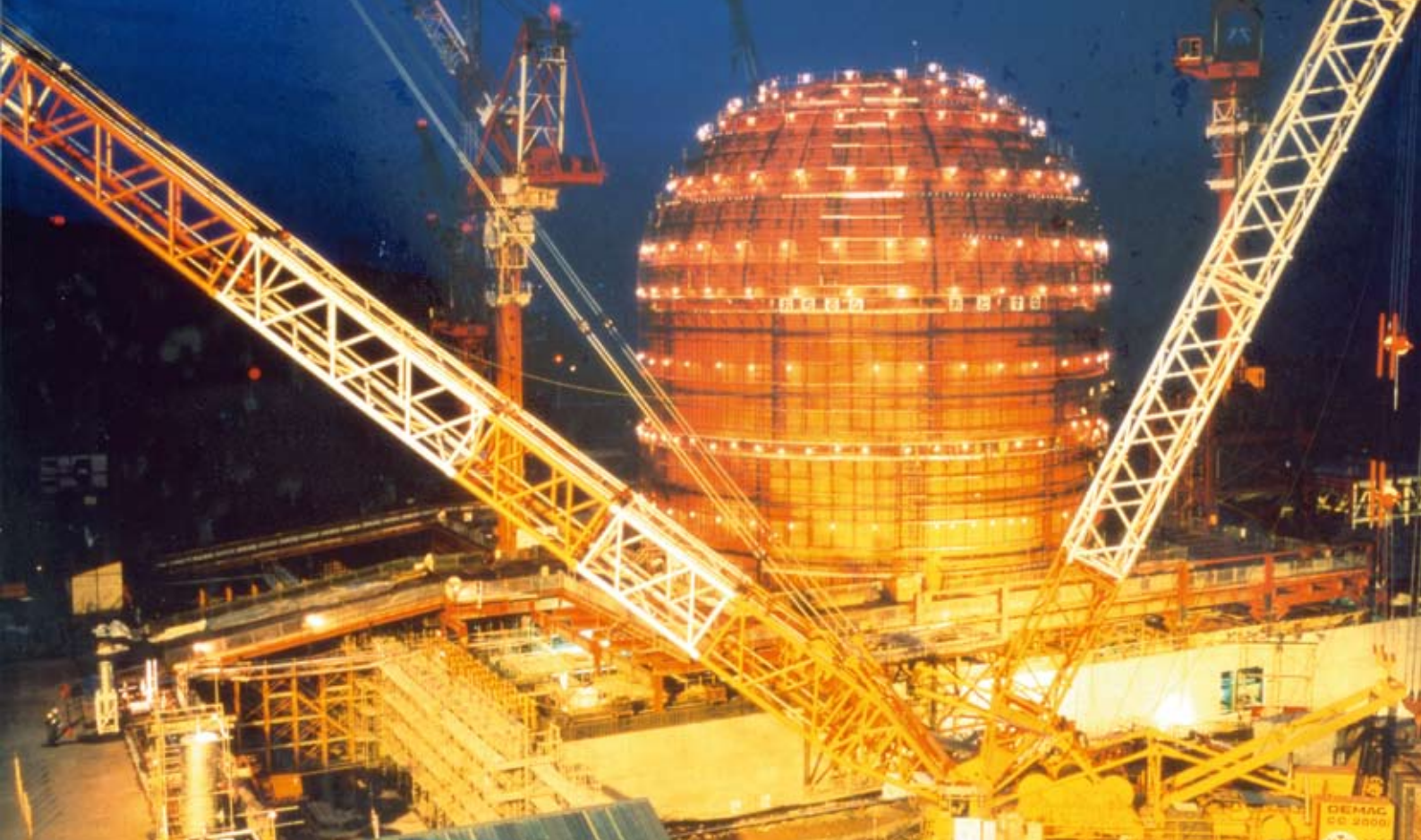
Le lancement d'un programme électronucléaire peut prendre au moins dix ans. La centrale nucléaire de Tomari en construction au Japon. (Source : Mitsubishi Heavy Industries, Ltd.)
