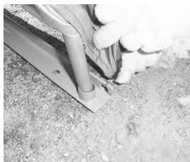
④テントベースの四つ角のフックに、テントのリングを引っ掛けてテントに張りを出します。
