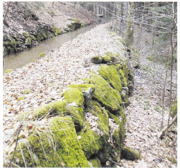
Trockenmauer oberhalb und unterhalb des Wuhres
