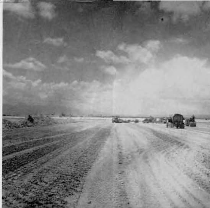
Placing Coral Fill
