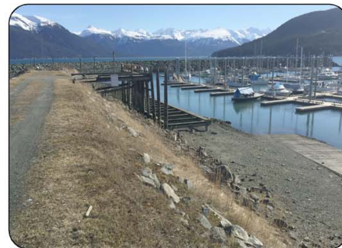
F DREDGE AREA (D) LOOKING EAST
