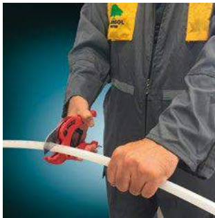
1. CORTAR LA TUBERÍA RECTA
