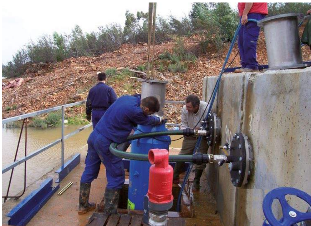
Instalación de bombas sumergibles.
