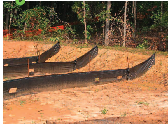
Fixation correcte des barrières géotextile.
