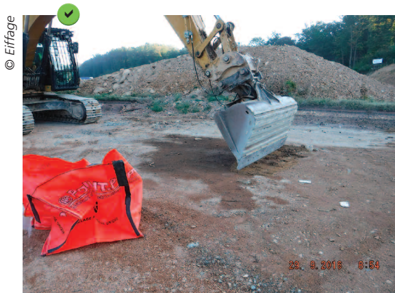
Exemple de la récupération de terres polluées aux hydrocarbures et de leur stockage dans un big bag étanche.
