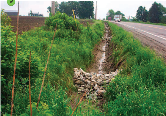
Fossé avec seuils en série.
