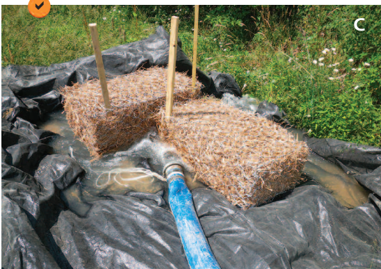
C, D - Exemples de deux dispositifs temporaires de protection des exutoires (utilisés pour quelques jours uniquement). L'option « botte de paille » n'est pas la plus économique ni la plus efficace.
