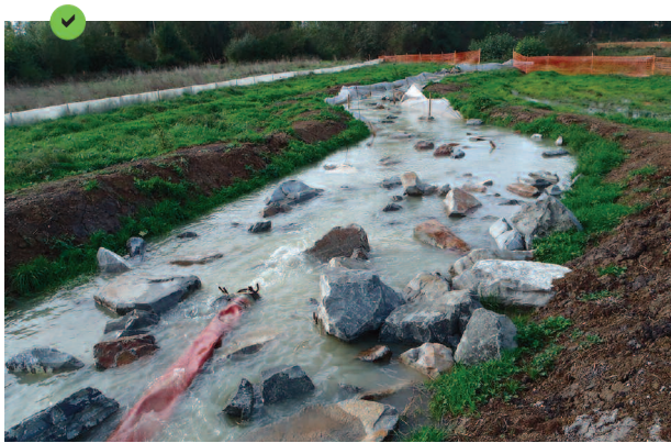
Rejet temporaire au sein d'une dérivation provisoire équipée de blocs dissipant l'énergie hydraulique.
