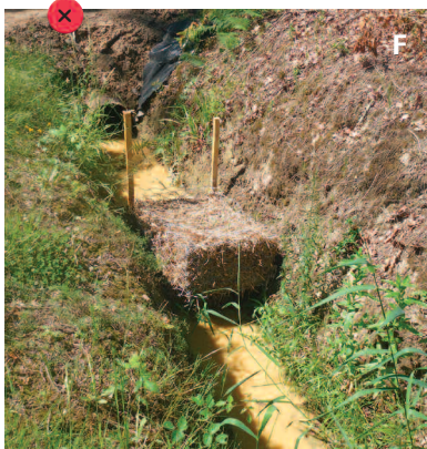
E, F - Bottes de paille insérées dans un gabion et mises en place en aval du point de rejet. La mauvaise installation de ces gabions rend les dispositifs inefficaces voire contre-productifs.
