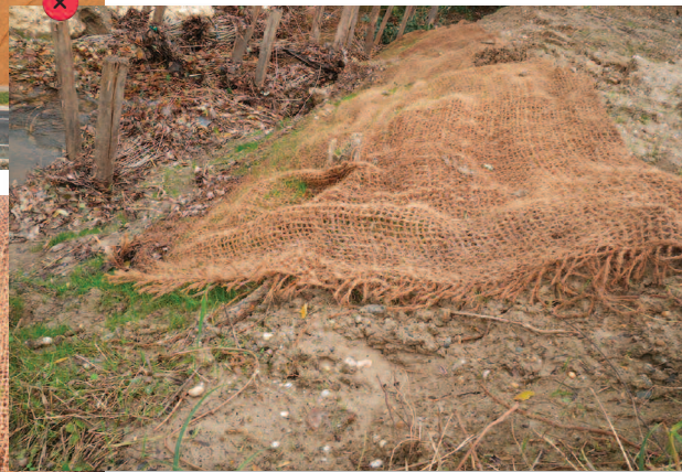
Ancrage insuffisant du filet en amont.
