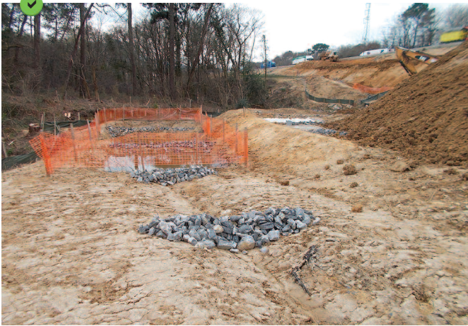
Fossé équipé de seuils en série en amont immédiat d'un piège à sédiments.
