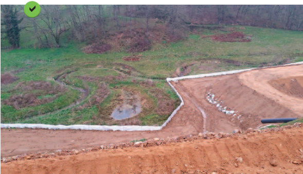
Barrière de rétention longeant un cours d'eau.
