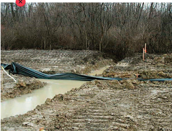
Ne pas installer de barrières de rétention en travers des cours d'eau.
