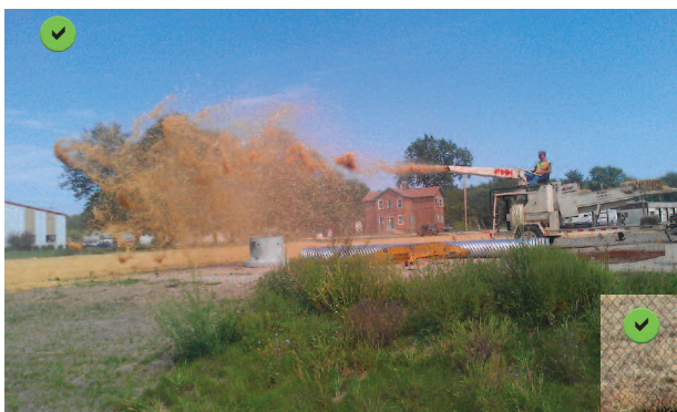
Exemple d'un paillage en cours.
