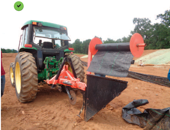
Dispositif d'installation automatique des barrières de rétention.
