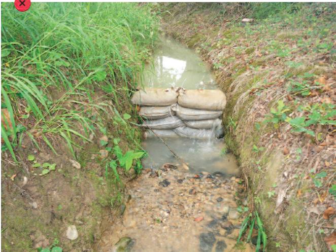
Seuil anti-érosion constitué de sacs de graviers placés au fond du fossé. Pour éviter un contournement sur les côtés, une surverse au centre aurait amélioré le dispositif.
