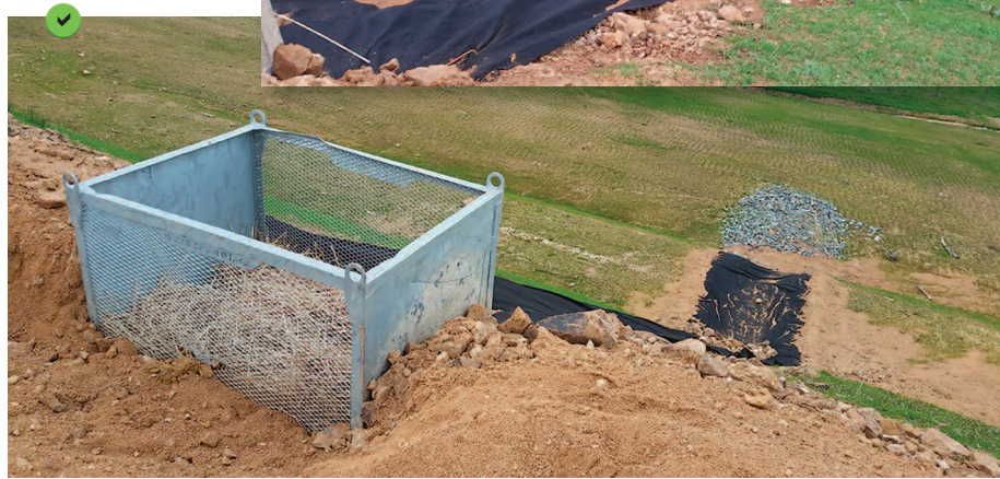
Descente d'eau provisoire sur remblai de grande hauteur, avec passage au travers d'une cage de filtration (en amont) et d'un dispositif anti-érosion (en aval).
