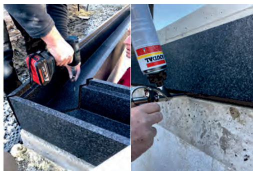
4. Steine auf Betonkronen befestigen
