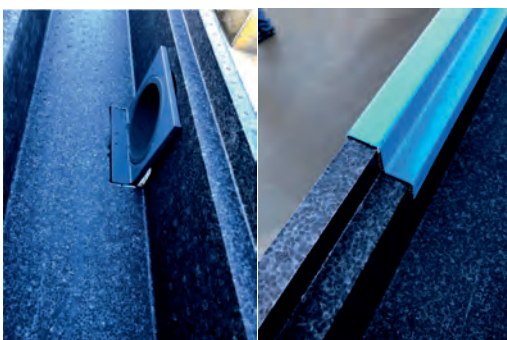
6. Abläufe und Blech montieren
