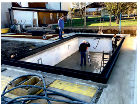
3. Mit Stellfüßen nivellieren und ausrichten
