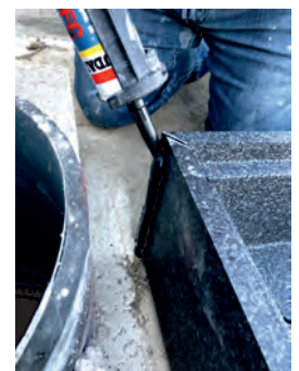
5. Gehrungen und Schrauben mit Montagekleber verschließen
