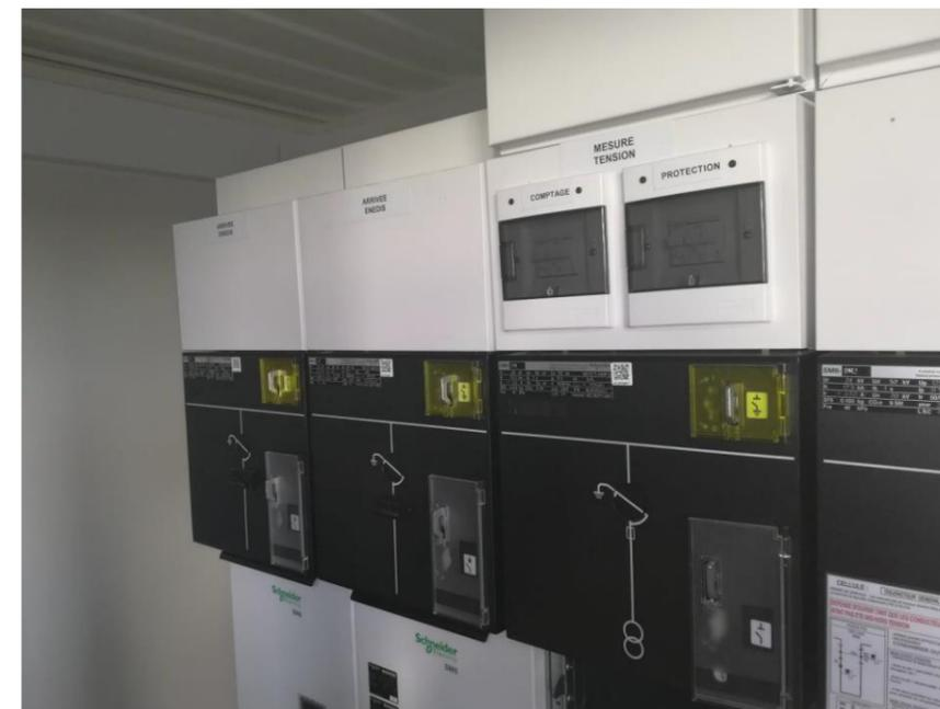
**Figure 8 : Container de conversion d'énergie comprenant l'électronique de puissance et le poste HTA (Source : Rapport de présentation du projet d'ALBIOMA, Décembre 2019)**
