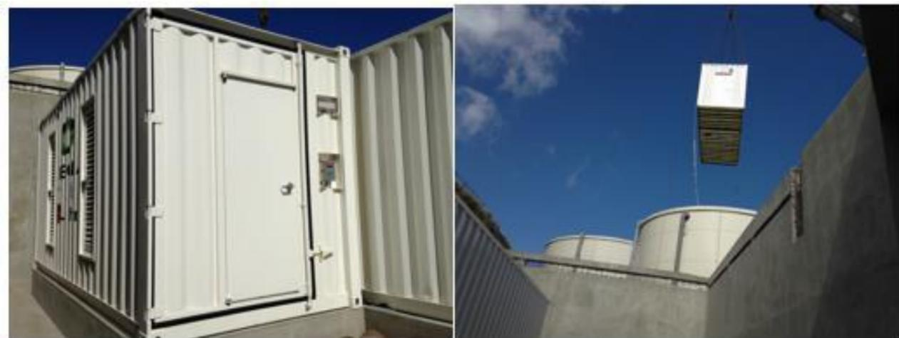
**Figure 6 : Containers TESLA accueillant les batteries de stockage (1) (Source : Rapport de présentation du projet d'ALBIOMA, Décembre 2019)**
