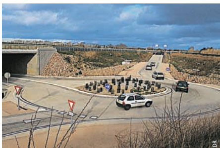
Photo 1 Giratoire en béton Concrete roundabout
