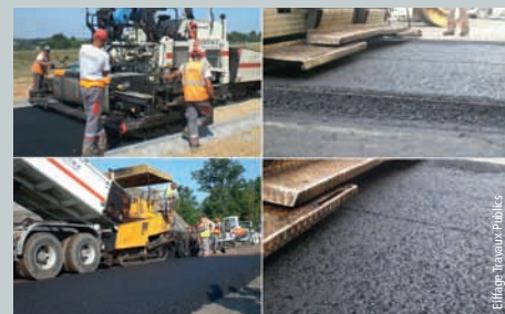
Mise en œuvre d'enrobés GB5
