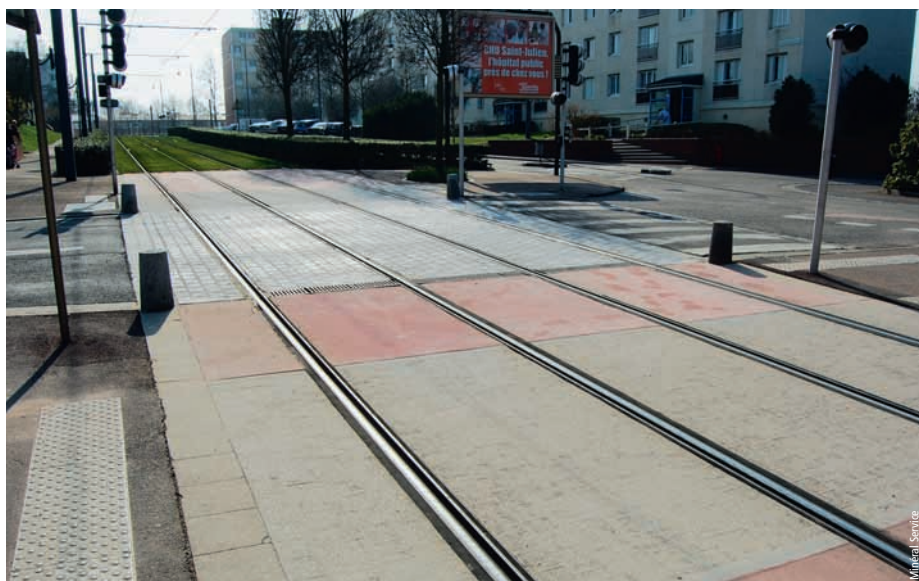
Carrefour tram/ chaussée
