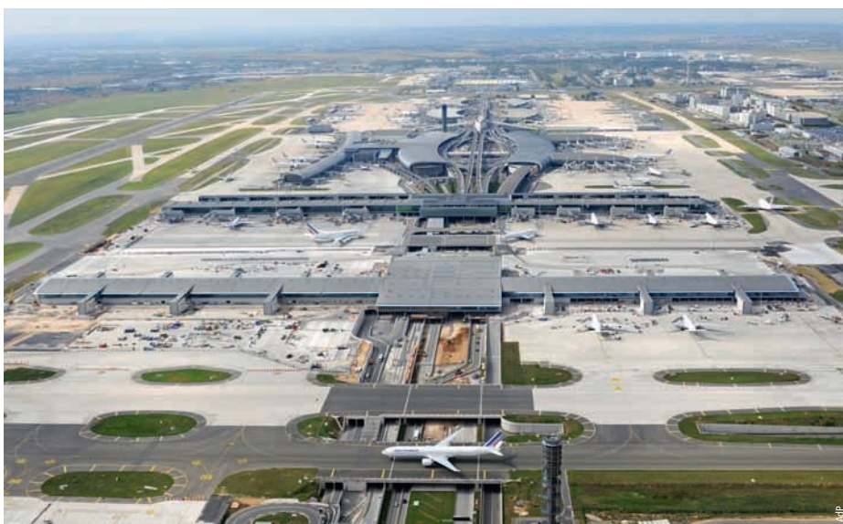
Vue générale de l'aéroport de Roissy et, au premier plan, du satellite S4 en travaux
