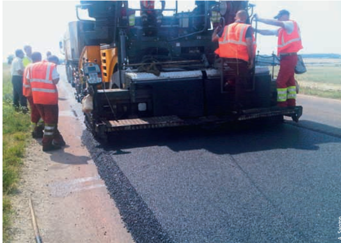
Photo 3 Application de l'enrobé par demi-chaussée Application of asphalt by half-pavement
