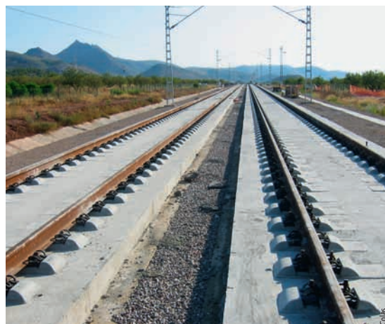
Voie béton de ligne à grande vitesse Concrete track of high-speed line
