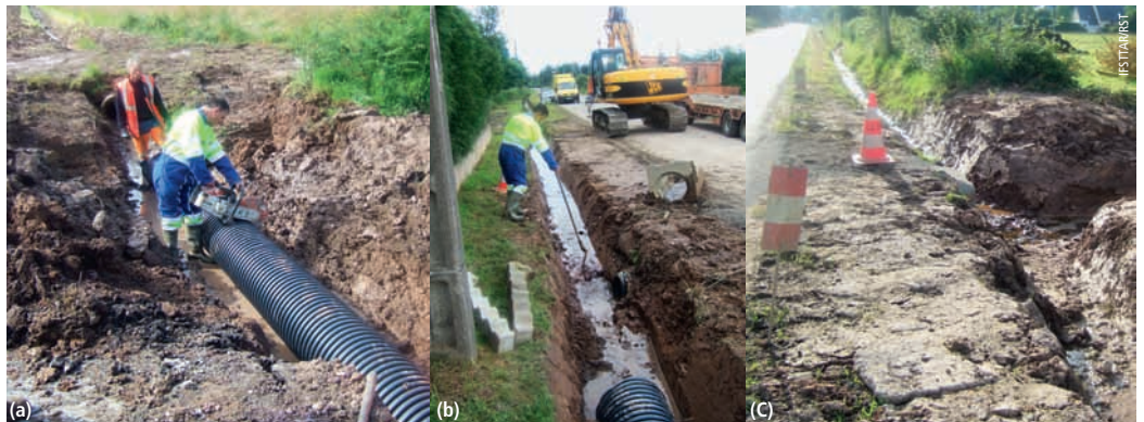
Photos 2 Travaux d'assainissement : reconstruction de la traversée de chaussée (a) et des exutoires amont (b) et aval (c) Drainage works: reconstruction of the pavement crossing (a) and of the upstream (b) and downstream (c) outlets
