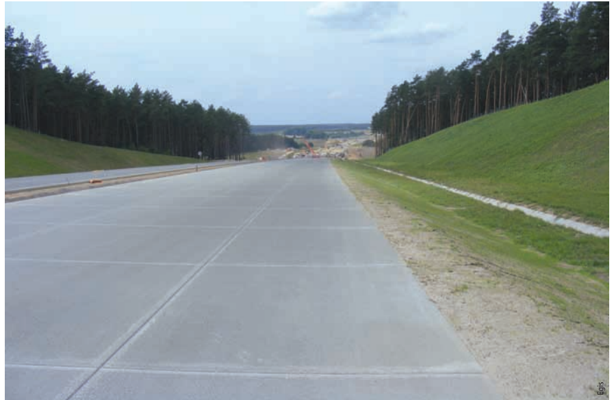
Chaussée en béton de l'autoroute A2 SII Concrete pavement of motorway A2 SII
