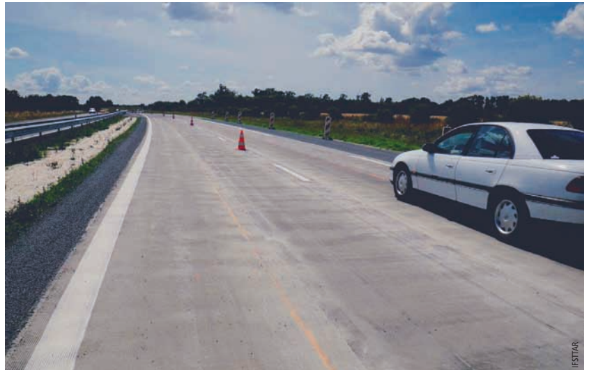
Section d'essai de Loire-Atlantique (construite en mai-juin 2011) 75 m d'EHFR (au premier plan) suivis de 75 m d'EHFG Test section in Loire-Atlantique region (built in May-June 2011) 75 m of EHFR (foreground) followed by 75 m of EHFG
