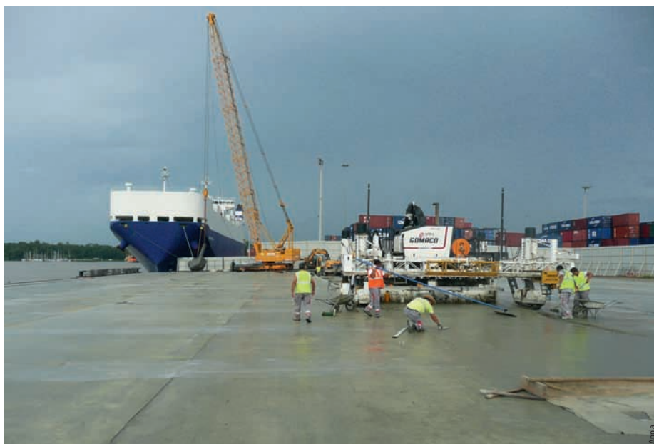
Photos 2 et 3 Bétonnage
