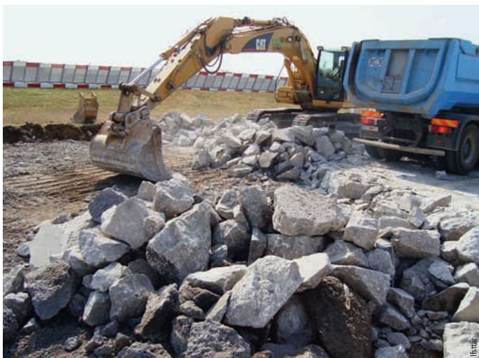
Photos 2 et 3 Déconstruction de dalles d'aéroport puis recyclage à 100 % dans une dalle de mêmes performances fonctionnelles Deconstruction of airport slabs and 100% recycling in a slab of same functional performance
