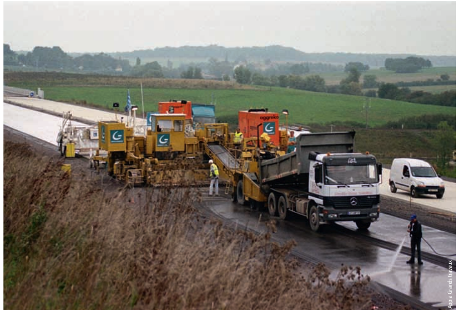
Le déroulement du chantier RN4, déviation de Bebing-Himling Works on highway RN4, Bebing-Himling diversion
