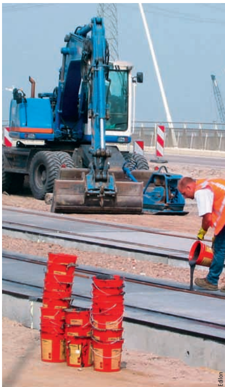
Photo 8 Rail noyé ou ERS – coulage de la résine Embedded rail or ERS – placing of resin
