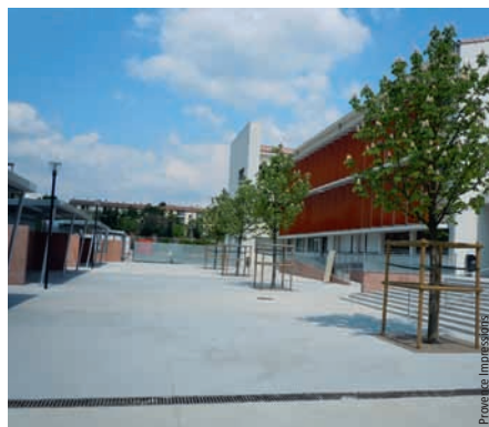
Les escaliers en béton coulé en place
