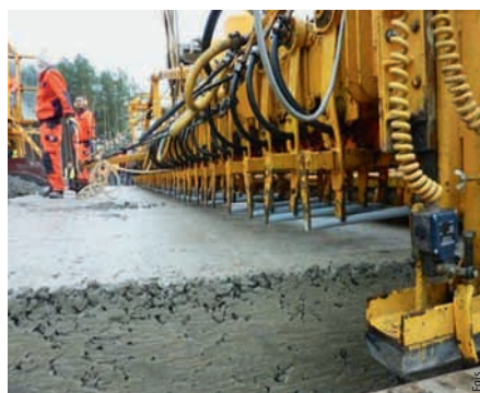
Photos 7 Mise en œuvre de la couche de base Placement of base course
