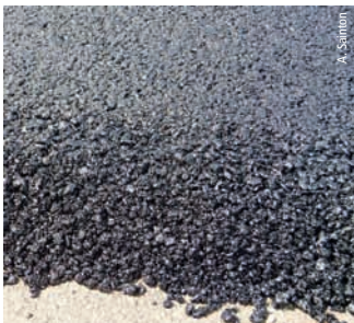
Photo 2 Aspect de l'enrobé après mise en œuvre Appearance of asphalt after laydown
