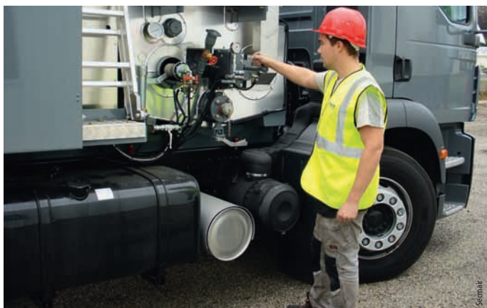
Photo 2 Contrôle thermique du stockage des enrobés Thermal control of asphalt storage
