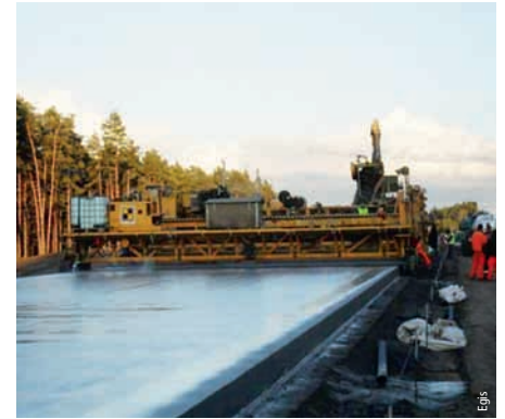
Photo 9 Protection de la couche de roulement avec un film plastique Protection of wearing course with plastic film
