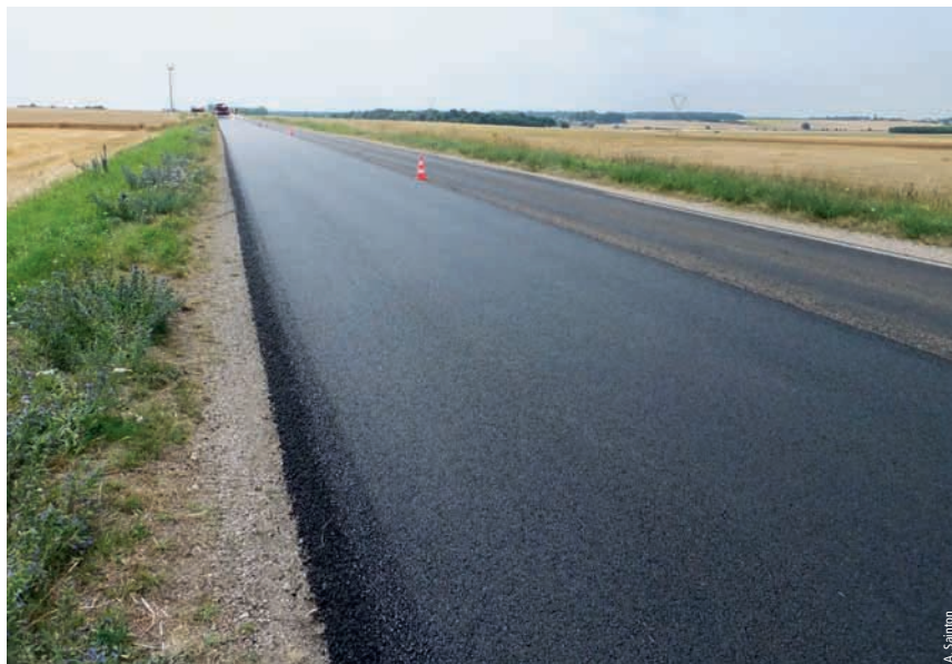
Une première demi-chaussée en enrobés A first asphalt half-pavement
