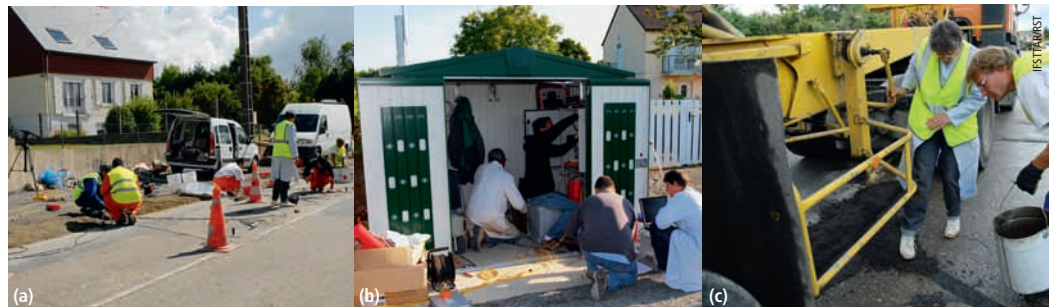
Photos 5 Zone instrumentée Distribution des capteurs (a) local technique (b) surprotection des capteurs à la mise en œuvre (c) Instrumented area Sensors installation (a) Technical shed (b) Over protection of sensors before laying (c)
