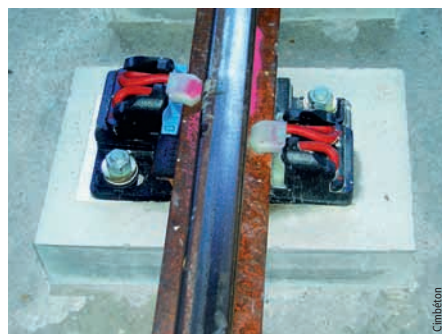
Photo 4 La selle métallique équipée d'attaches élastiques et d'une semelle anti-vibratile Steel tie-plate equipped with elastic rail fasteners and an anti-vibration tie-plate
