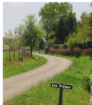
Photos 4 Aspect général de l'enrobé Biocold dans le département de la Sarthe après trois années General appearance of Biocold asphalt in the Sarthe region after three years
