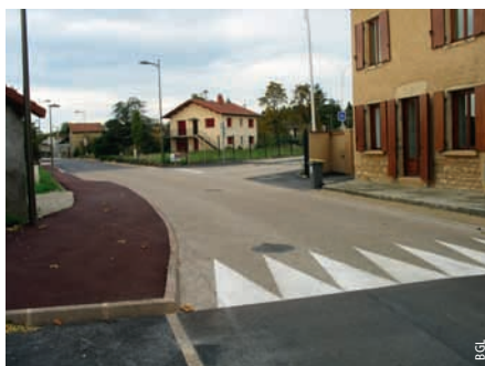
Carrefour en béton à Génas
