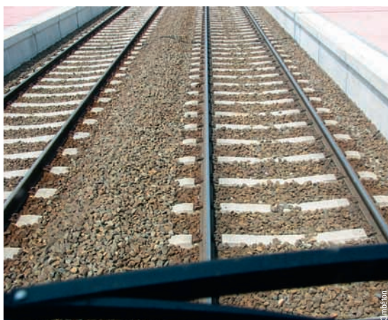
Voie ballastée de ligne à grande vitesse Ballasted track of high-speed line
