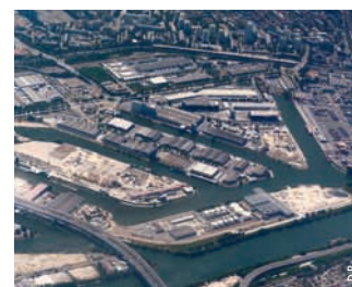
Le port de Gennevilliers avant son extension
