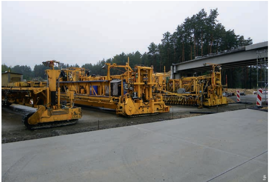
Photo 2 Machine à coffrage glissant pour une mise en œuvre bicouche Slipform machine for two-layer application
