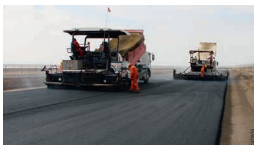
Réhabilitation de l'autoroute panaméricaine
