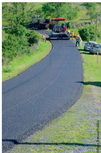
Photo 5 Mise en œuvre de l'enrobé Biocold (43) Laydown of Biocold asphalt (Haute Loire region)
