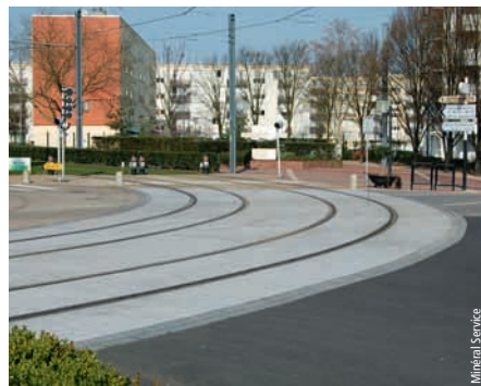
Les voies réhabilitées du tramway de Rouen
