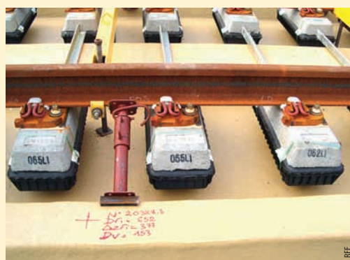
Photo 5 Rails fixés sur traverses béton – Système Stedef Rails set on concrete sleepers – Stedef system
