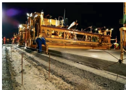
Photo 8 Mise en place du film de protection Placement of protective film
