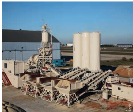
Photo 4 La centrale à béton installée sur le site
