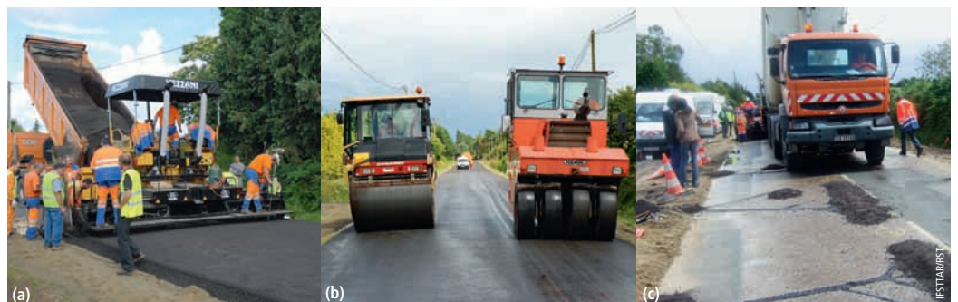
Photos 6 Atelier de mise en œuvre : Répannage (a) et compactage (b) en section courante - au droit de la zone instrumentée (c) Laying equipment: finisher (a) and compaction (b) in the current section - in the instrumented area (c)
