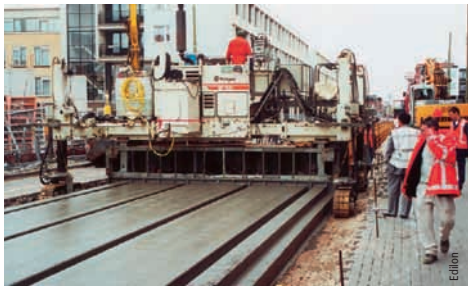
Photo 7 Rail noyé ou ERS – bétonnage et réalisation des engravures à la machine à coffrage glissant Embedded rail or ERS – Slipform placement of concrete and channels
