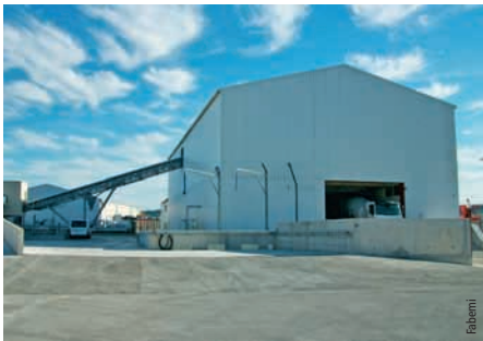
La centrale à béton de Vitrolles
