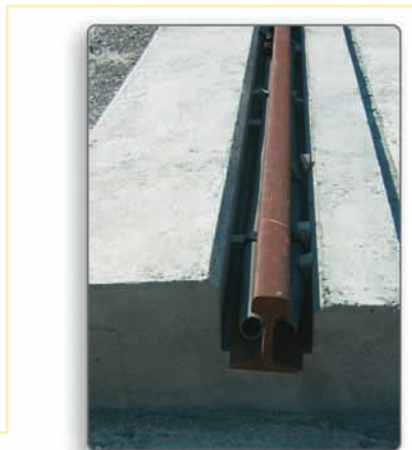
Photo 7 Rail noyé ou ERS – bétonnage et réalisation des engravures à la machine à coffrage glissant Embedded rail or ERS – Slipform placement of concrete and channels
