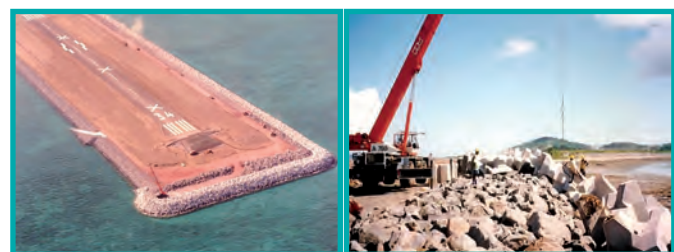
Construction de la piste 1995 (SOGREAH, 1995)
