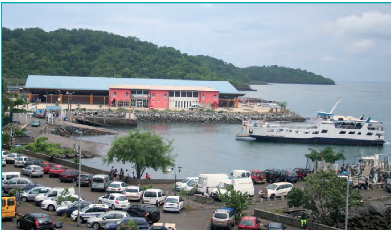
Barge et gare maritime de Mamoudzou
