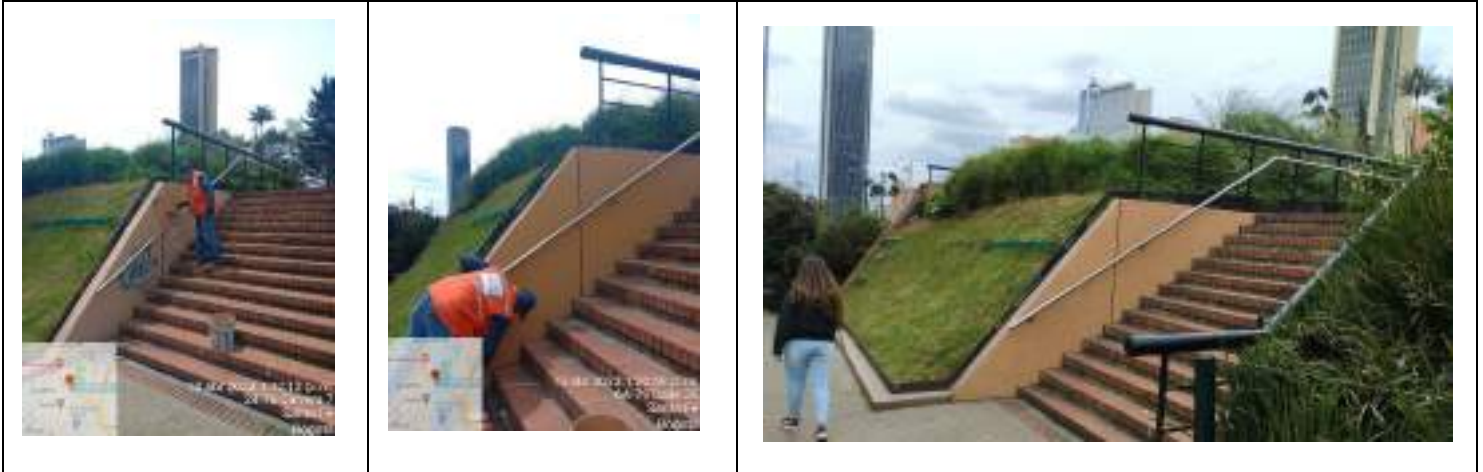
Pintura de materas, muros y elementos gris basalto
