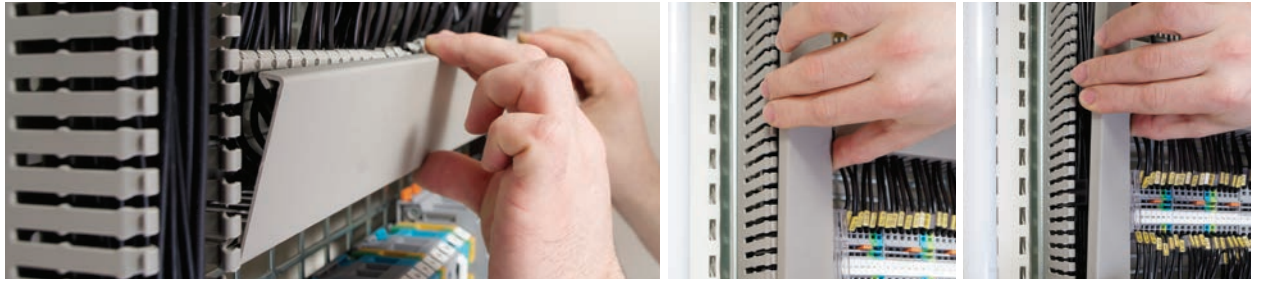
Kablo Kanal Kapağı Uygulama
