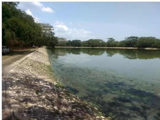
Foto 1: Laguna estabilización – Municipio de Sabanalarga
