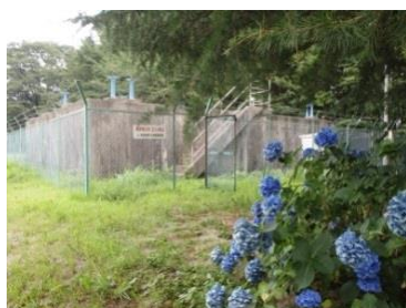
穴沢第1配水池
