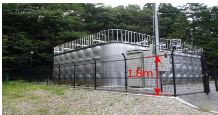
図 5.4 適正な外周フェンス（板室本村低区配水池）
