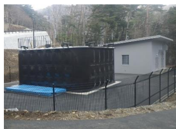
塩の湯ポンプ場
