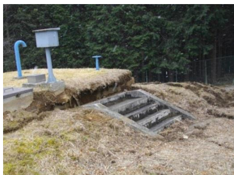
(熊久保配水池)
