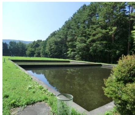
緩速ろ過（要害浄水場）
