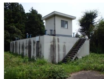
高林第2配水池
