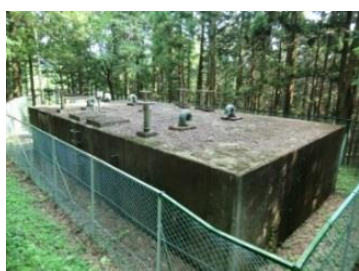
宇都野配水池
