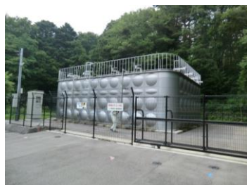
板室本村低区配水池
