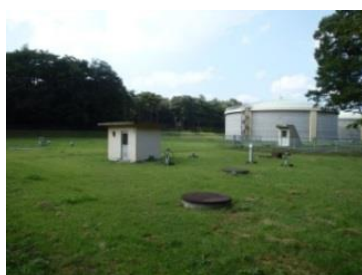
北那須配水池
