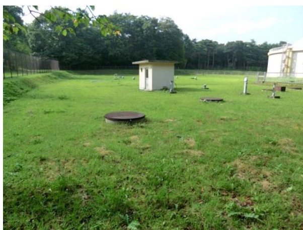
図 3.8 北那須配水池
