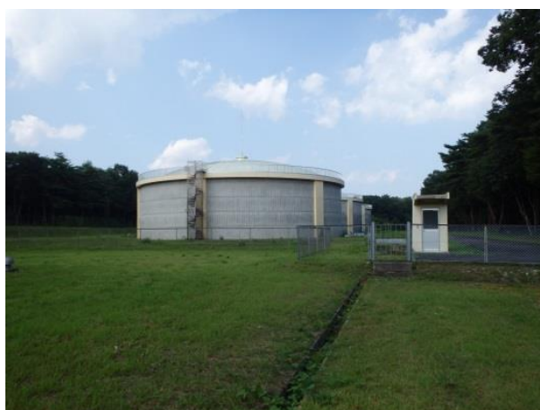
図 3.9 北那須水道折戸調整池
