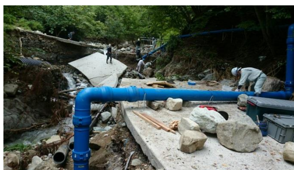
(復旧工事の様子)
