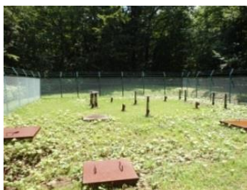
新湯第2配水池
