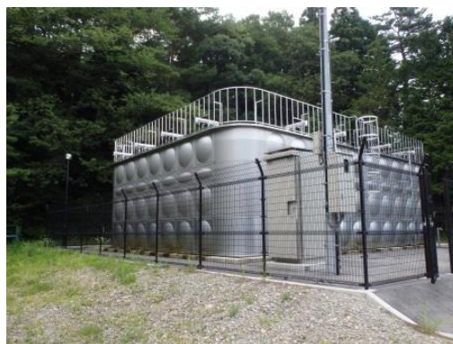
(板室本村低区配水池)
