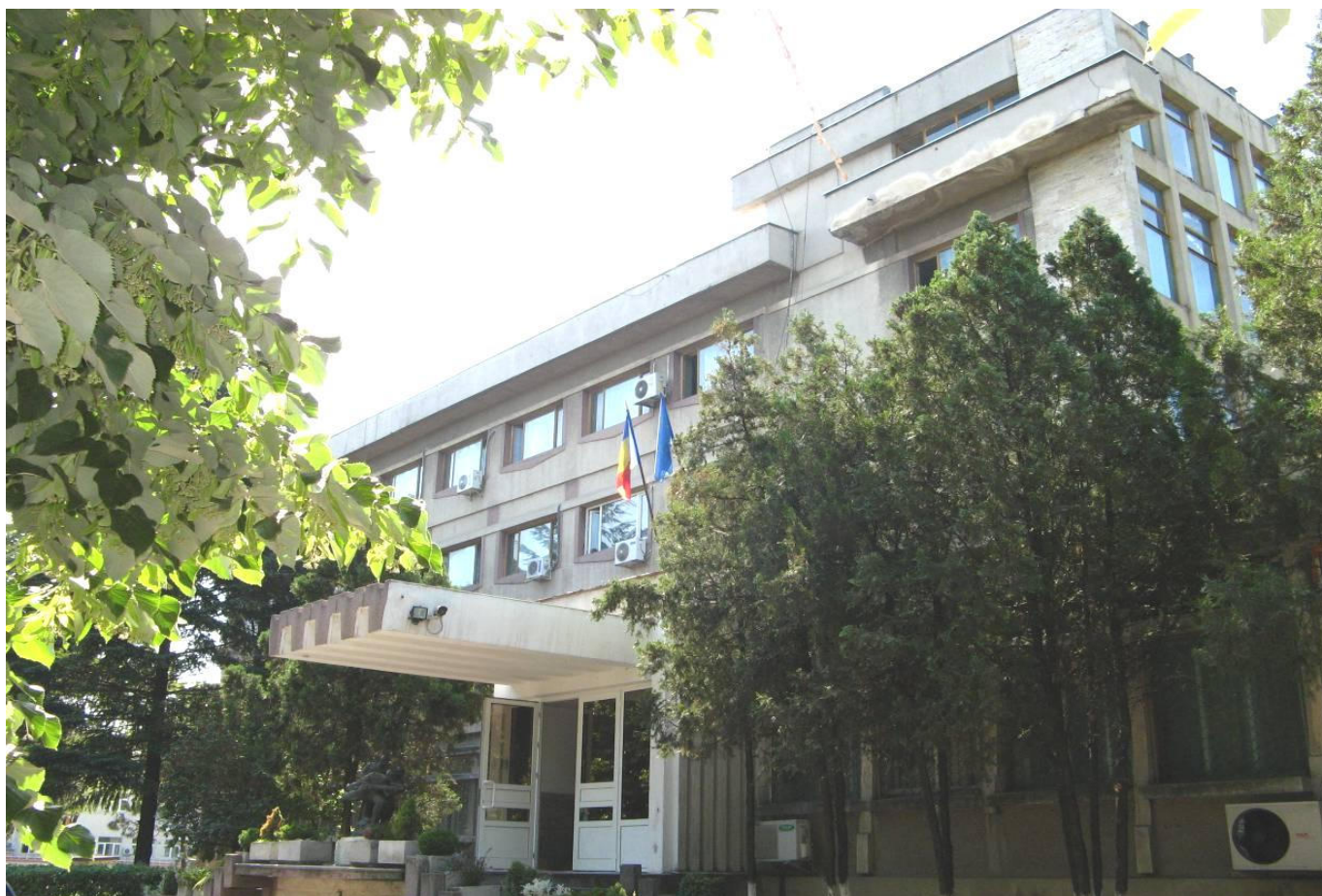
Pavilionul X (fost sediu al Direcției Informatică și Automatizarea Conducerii Trupelor și Centrului de Calcul al Armatei) din Bd. Drumul Taberei nr. 7-9, sector 6, sediu al Comandamentului Comunicațiilor și Informaticii din anul 1997.
