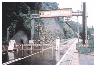
【大雨による通行規制状況】
