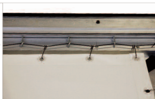
Système de tension de la toile.
