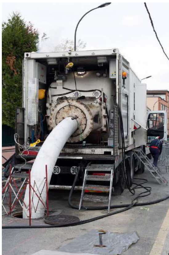
Travaux de chemisage
