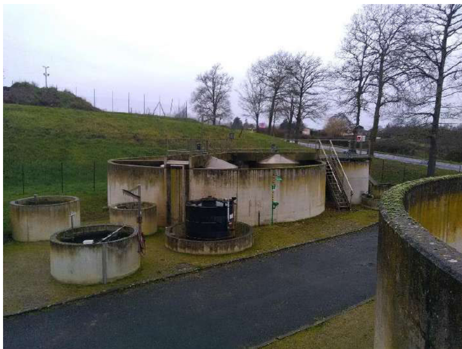
La station d'épuration de Lurcy-Lévis
