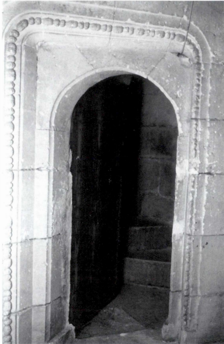
Fig. 18. Juan de Badajoz « le Jeune ». Porte d'arc en biais de l'escalier. Photo de l'auteur
