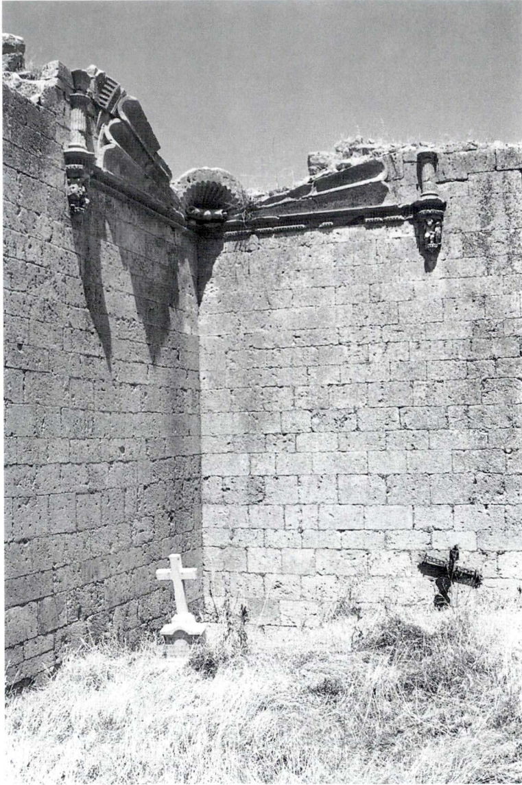
Fig. 6. Belmonte de Campos. Chapelle de Don Pedro Manuel. Trompe d'angle. Photo de l'auteur
