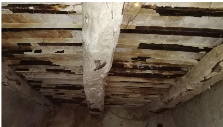
Foto 4.14 – Solaio costituito da travi e travetti in legno e pianelle in cotto.
