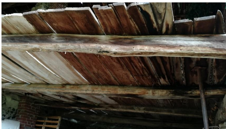
Foto 4.15 – Solaio costituito da travi e tavolato in legno.
