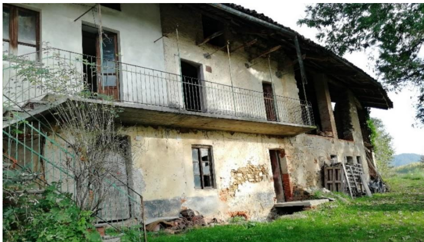
Foto 4.2 – Vista generale dell'edificio in esame.
