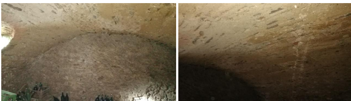
Foto 4.16 – 4.17 – Volta a botte lovale interrato.
