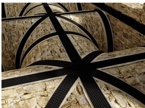
Immagine 3.19 – Placcaggio con fasce di materiale composito. www.edilportale.com . [15].
