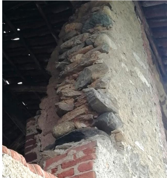
Foto 4.6 – Particolare ingranamento trasversale.
