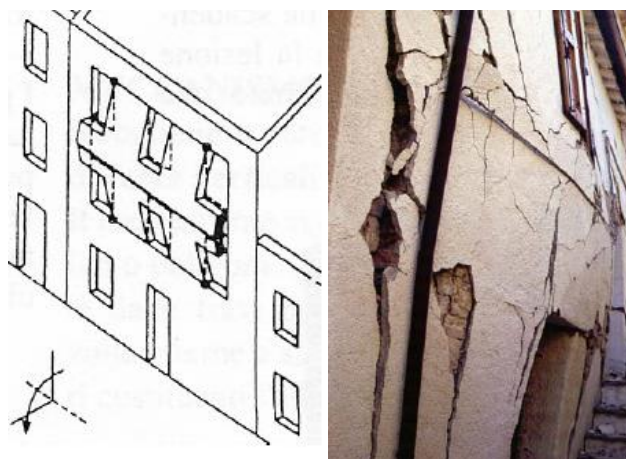
Immagine 3.10 – Esempio di meccanismo di flessione verticale. Foto da MEDEA – Papa, Zuccaro. 2003. Immagine tratta da "Repertorio dei meccanismi di danno, delle tecniche di intervento e dei relativi costi negli edifici in muratura – definizione di modelli per l'analisi strutturale degli edifici in muratura". G.C. Beolchini, L. Milano, E. Antonacci. 2005 [12].
