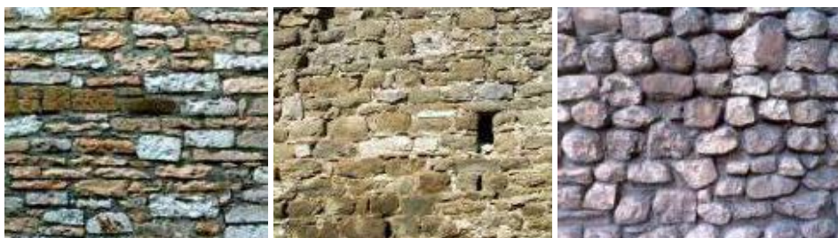
Immagine 3.6 – Qualità della malta/efficace contatto fra elementi/zeppe. Da sinistra si ha: MA. Rispettato, MA. Parzialmente Rispettato, MA. Non Rispettato. Immagini tratte da "A Method for the analysis and classification of historic masonry", A. Borri. 2015 [8].
