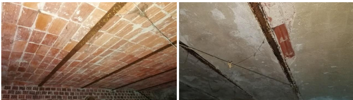
Foto 4.12 – 4.13 – Solaio in voltini in mattone forato con travetti in profilato in acciaio IPN160 x 75
