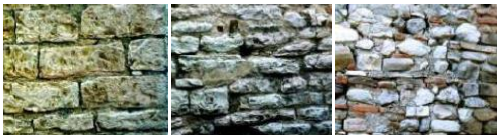
Immagine 3.3 – Forma degli elementi resistenti. Da sinistra si ha: F.EL. Rispettato, F.EL. Parzialmente Rispettato, F.EL. Non Rispettato. Immagini tratte da "A Method for the analysis and classification of historic masonry", A. Borri. 2015 [8].
