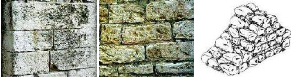
Immagine 3.5 – Dimensione degli elementi resistenti. Da sinistra si ha: D.EL. Rispettato, D.EL. Parzialmente Rispettato, D.EL. Non Rispettato. Immagini tratte da "A Method for the analysis and classification of historic masonry", A. Borri. 2015 [8].
