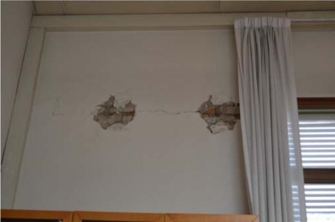
*Figura 4.10- Distacco dell'intonaco in una delle biblioteche-aule studio del secondo piano*
