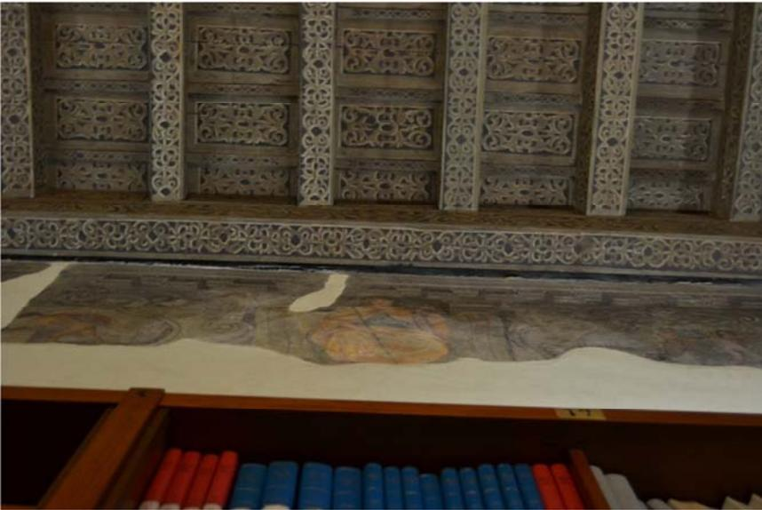
*Figura 4.3- Dettaglio solaio in legno ipotizzato scarico e appeso al solaio in laterocemento, piano secondo.*
