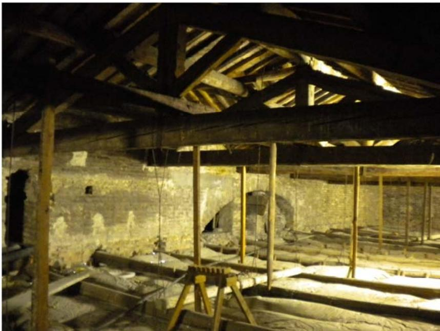
*Figura 4.4- Particolare del sottotetto in cui si possono vedere i materiali costitutivi della muratura, della copertura e in particolare il solaio di tipo cannicciato.*
