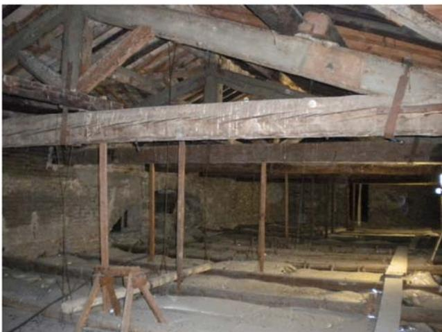
*Figura 4.11- Particolare della copertura dal quale si può riscontrare il degrado della capriata*
