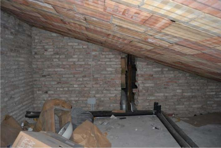
*Figura 4.1- Particolare del sottotetto in cui si possono vedere i materiali costitutivi della muratura e della copertura.*
