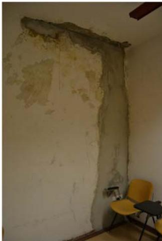
*Figura 4.9- Macchia in una delle aule didattiche al primo piano*
