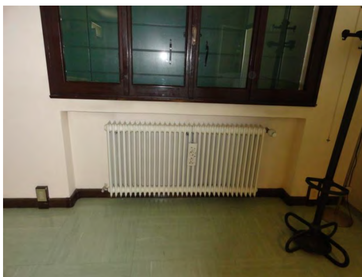
Figura 4.08 Nicchia di alloggio dei termosifoni
