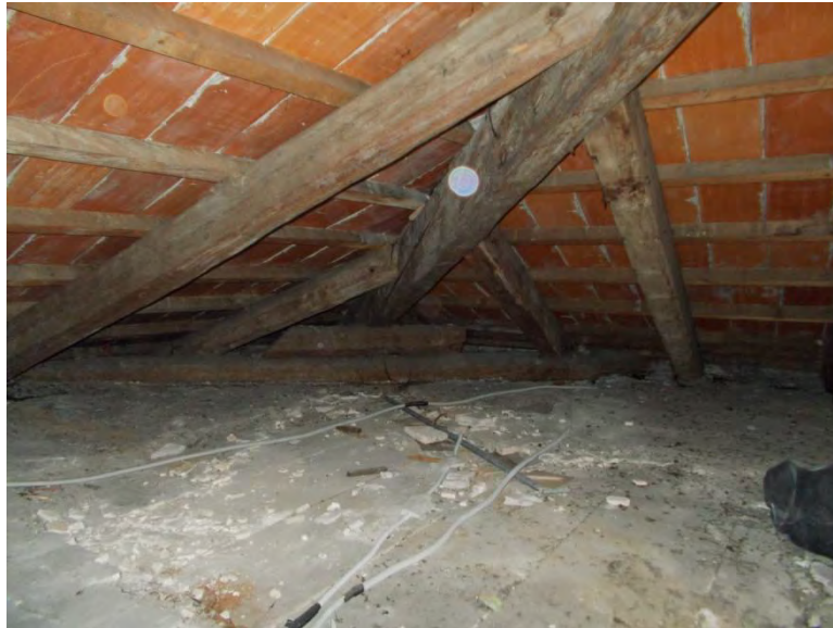
Figura 4.04 Copertura legno e tavelloni
