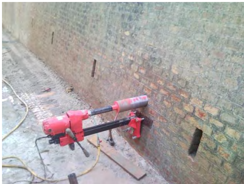
Figura 8.03 Prelievo di una carota di muratura
