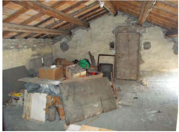
Figura 2.23 Ambiente utilizzato come deposito
