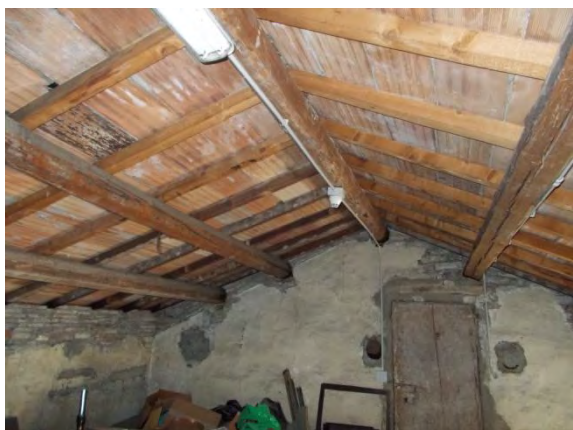
Figura 2.20 Ambiente utilizzato come deposito
