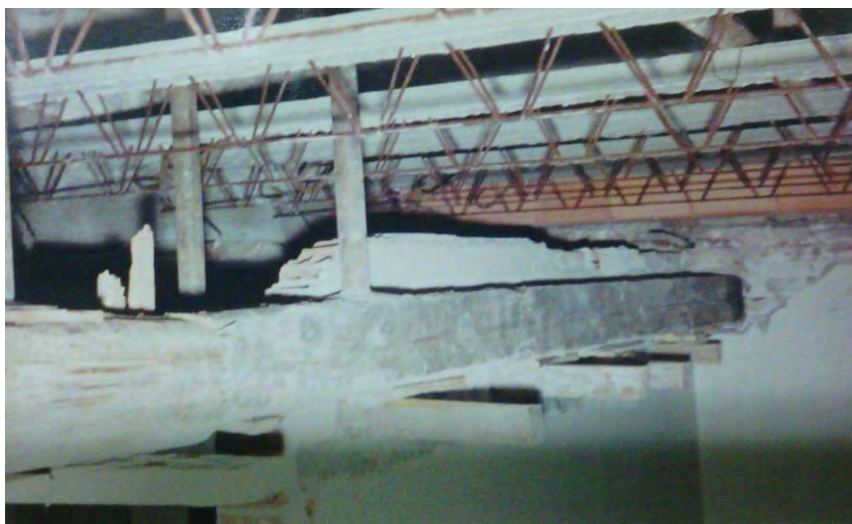
Figura1. 08 Intervento sostituzione solai lignei con solai in latero cemento nell' alloggio del custode
