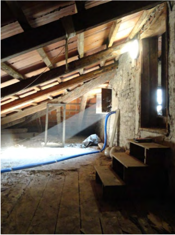
Figura 2.22 Ambiente utilizzato come deposito
