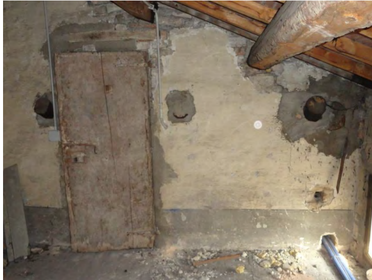
Figura 4.13 Parete del sottotetto
