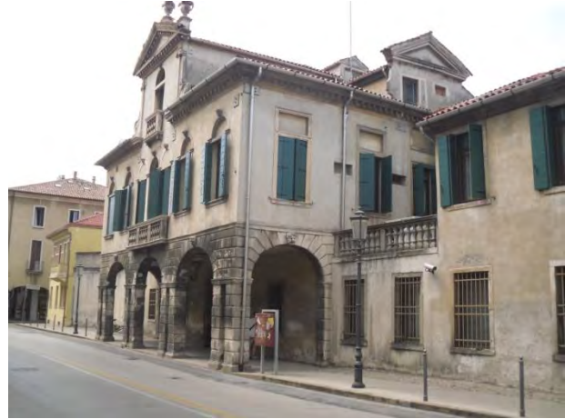
Figura 2.03 Vista lato est del portico
