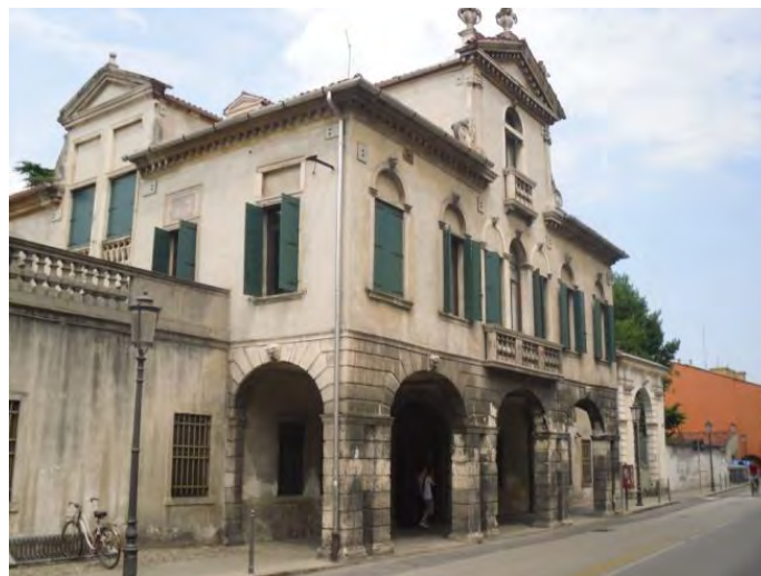
Figura 2.11 Prospetto ovest fotografato dalla strada
