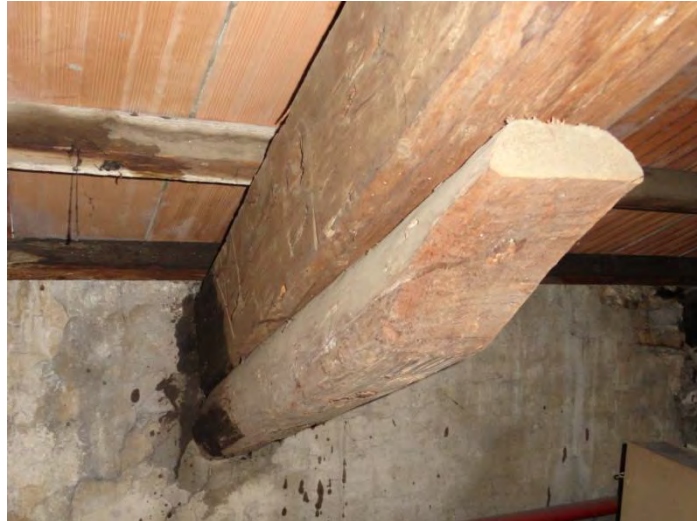
Figura 4.12 Intervento di supporto per una trave della copertura
