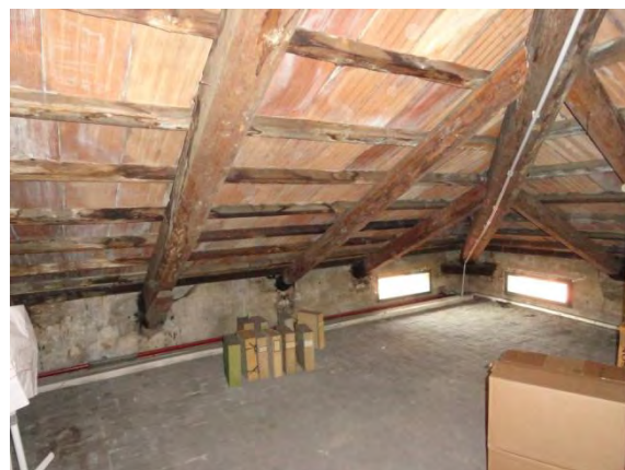
Figura 2.21 Ambiente utilizzato come deposito
