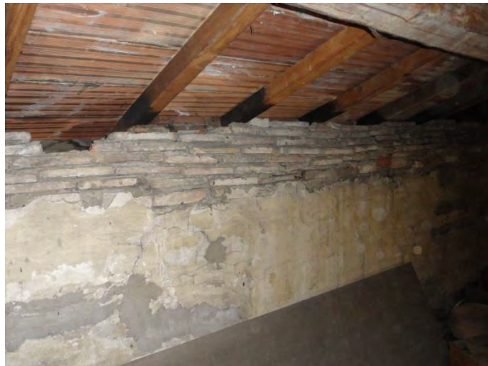
Figura 4.11 Appoggio della copertura sulle murature perimetrali
