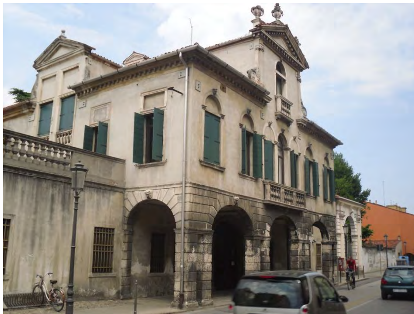
Figura 2.01 Prospetto sud dell' edificio
