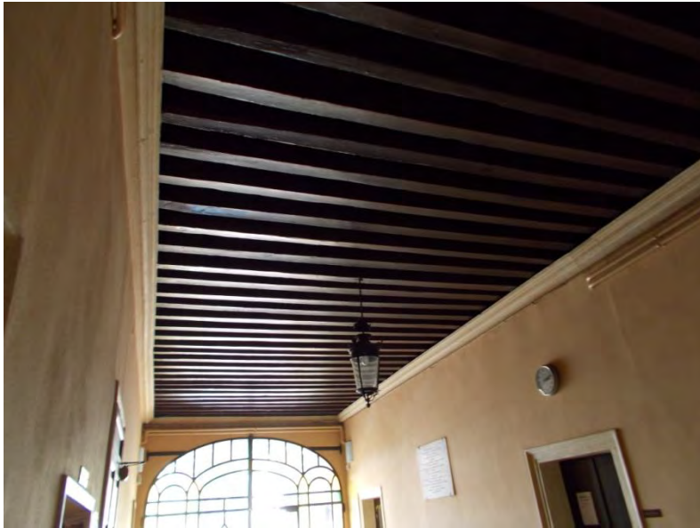
Figura 4.03 Solaio ligneo dell' atrio d' ingresso
