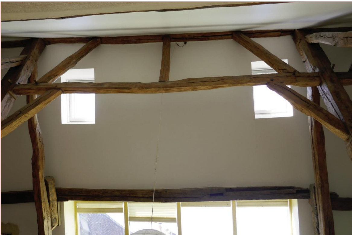
Au second plan, panne en remploi (mortaise non fonctionnelle).
