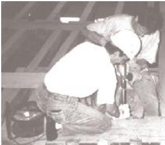
Photo 1 (Lavier) : Prélèvement à la tarière électrique
