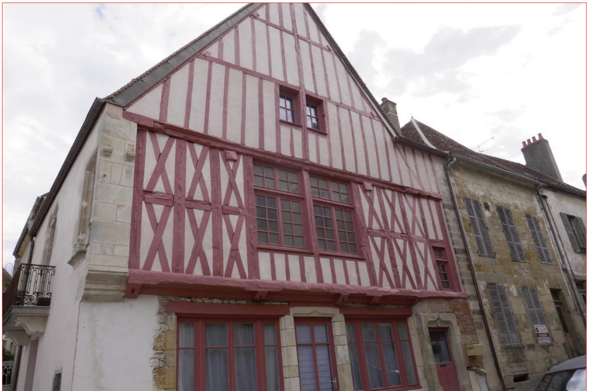
Photo 1 (en haut) : Marque 1 (I) avec patte d'oie sur un lien de contreventement dans la charpente. Photo 2 (en bas) : Façade sud à pan de bois.
