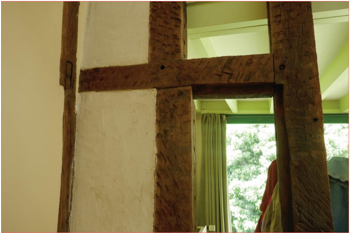
Photo 5 (en haut) : Feuillures des éléments d'une ancienne ouverture refermée - façade postérieure de la maison sud.
