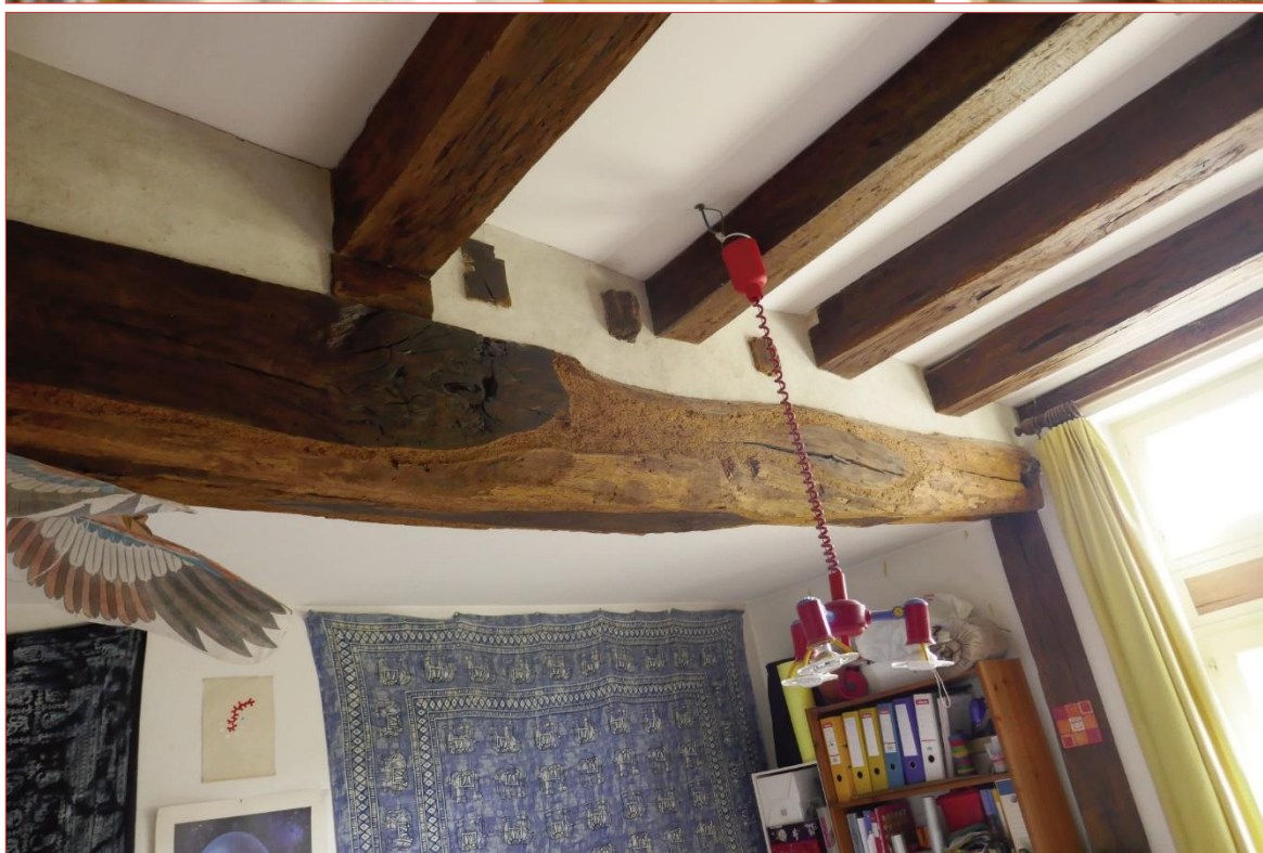
Photo 13 (en haut) : Marque 1 (I) avec contremarque (bâtonnet oblique) sur la face est de l'aiselier nord de la ferme ouest. A droite, ancienne marque rayée - maison nord.
