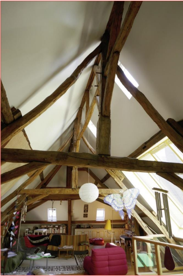
Photo 11 (en haut) : Vue de la charpente vers l'est - maison nord.
