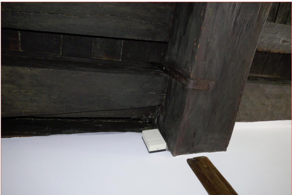
Photo 10 (en bas) : Poutre surnuméraire solidarisée à la poutre maîtresse du plafond du rez-de-chaussée par un étrier métallique - maison sud.
