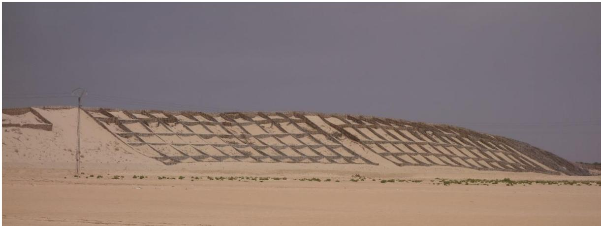
**Figure 2.6 : Technique de quadrillage pour la protection contre l'ensablement dans la région de Zarzine, au sud-ouest de Kébili.**
