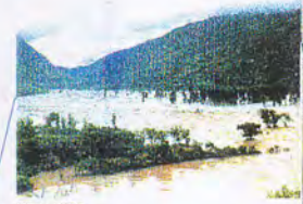
Photo N°20 Vallée du Paute au moment de la rupture du barrage 10/93
