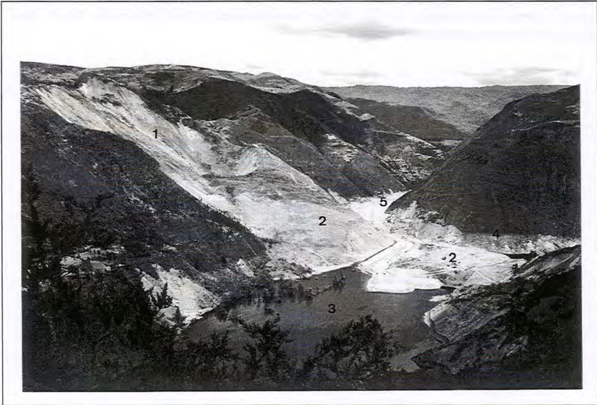
Photo II.1 - Vue générale, depuis l'ouest, du glissement de terrain de la Josefina après la rupture avec 1 : surface de rupture, 2 : accumulations de pied, 3 : lac résiduel, 4 : trace du niveau maximum atteint par le lac, 5 : secteur sinistré par l'onde de submersion (cliché F. Leone, octobre 1993).
