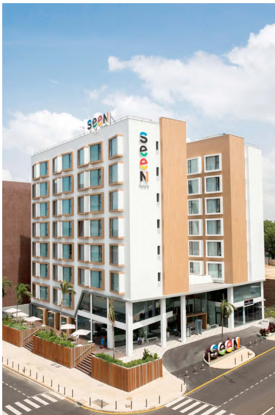
Fourniture de groupe détente directe, de CTA et de ventilo-convecteurs Hotel Seen Abidjan, Côte d'Ivoire ° Architecte : Design International
