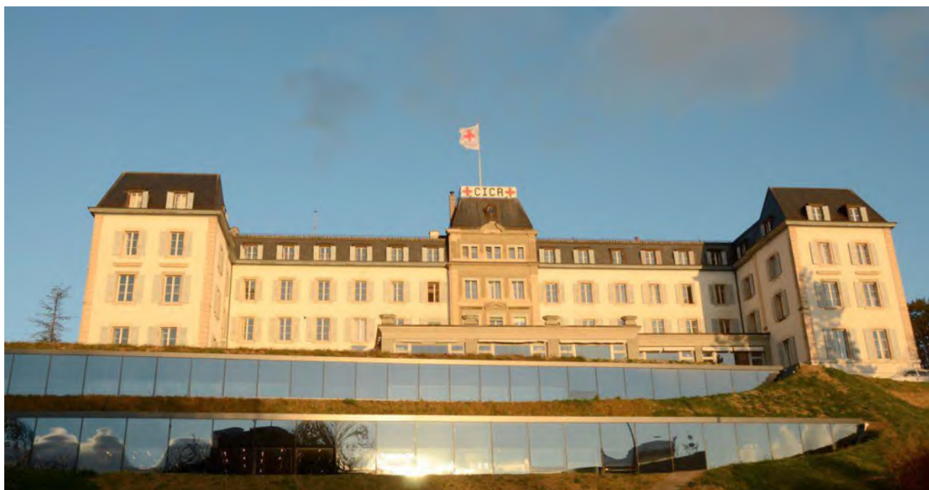
Fourniture de diffuseurs pour la rénovation ° Comité International de la Croix Rouge (CICR), Suisse
