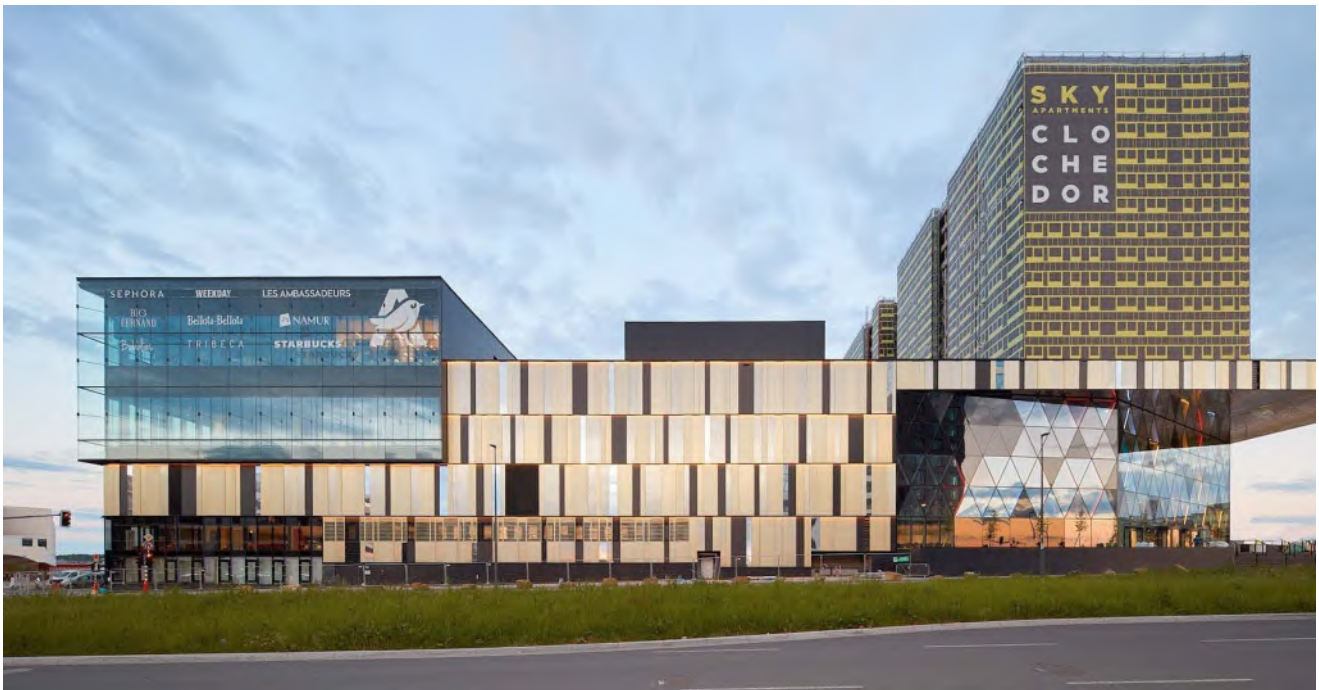
Fourniture de caissons de ventilation ° AUCHAN Cloche D'or, Luxembourg Architecte : Fabeck Architectes et Schemel Wirtz Architectes Associés
