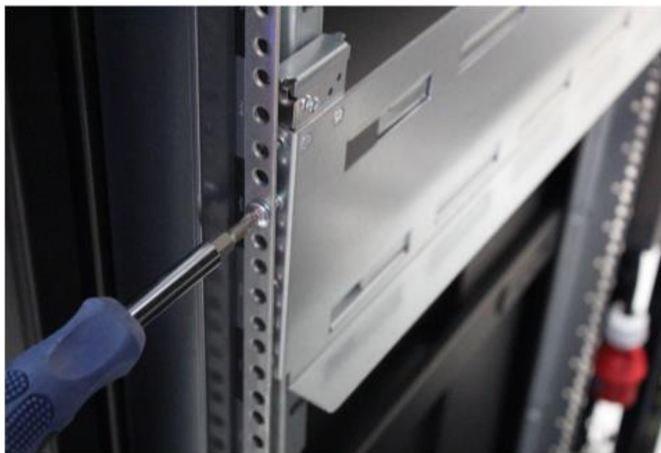
Рисунок 7. Крепление винтами передней части.
