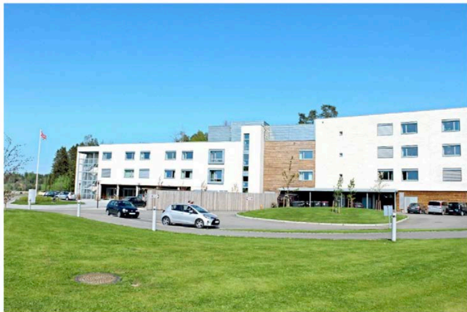
SYNKER: Grunnen rundt Bjønnessåsen bo- og aktivitetssenter synker. Dette har medført setningsskader ved inngangspartiet og i sansehagen. Foto: Therese Eskelund
