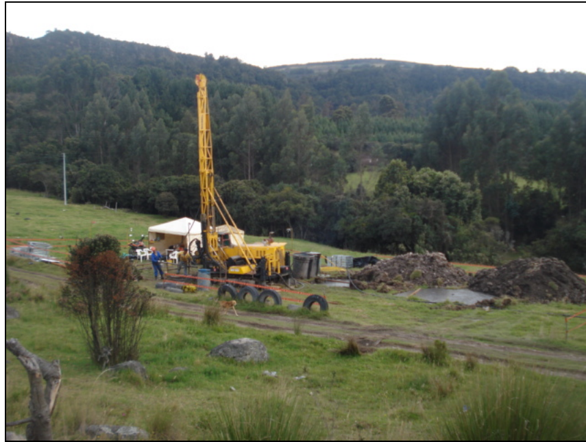
Figura 28. Montaje de la perforación Pozo Ráquira-1, vereda Firita Peña Arriba, municipio de Ráquira.
