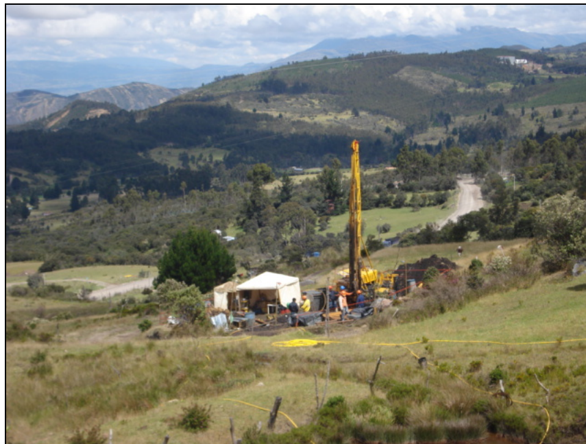
Figura 26. Montaje del Pozo Samacá-2, Vereda Loma Redonda, municipio de Samacá.
