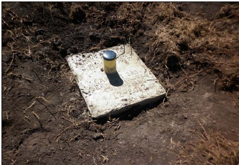
Figura 31. Placa en cemento que representa el sellado del Pozo Samacá-2, municipio de Samacá.
