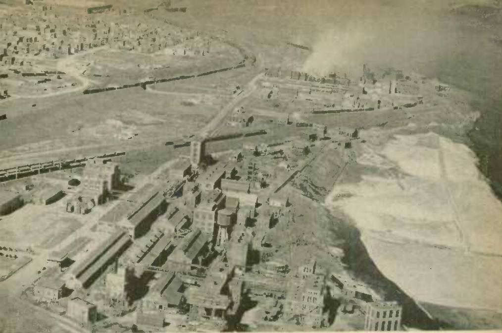
La fabrication du carbure de calcium et des produits chimiques à base d'acétylène est probablement la plus caractéristique des industries chimiques du Canada. L'énergie hydro-électrique et la recherche canadienne se sont conjuguées pour mettre sur pied l'industrie des produits chimiques organiques de Shawinigan-Falls (P.Q.).
