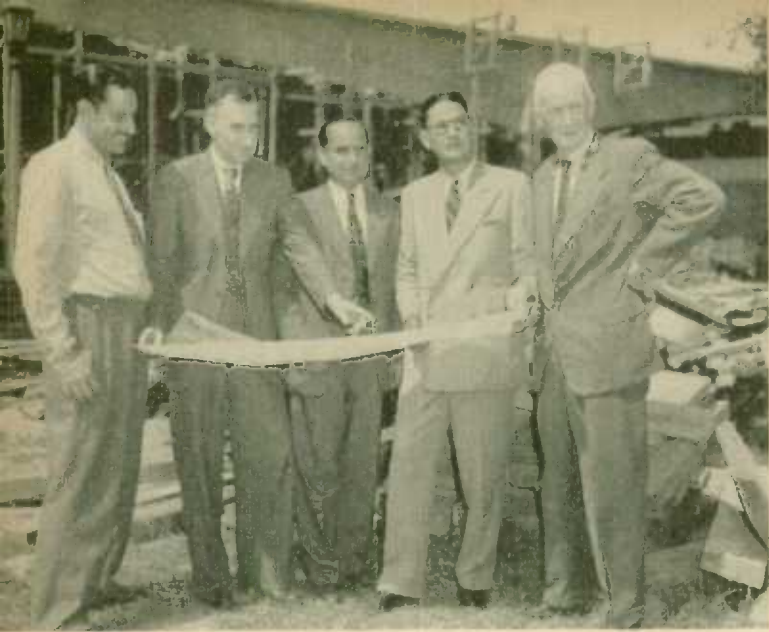
Venus au Canada en vertu du programme de coopération technique du Plan de Colombo, des membres de la mission pakistanaise des ponts et chaussées examinent les plans du pont Mackenzie-King, en construction à Ottawa.
