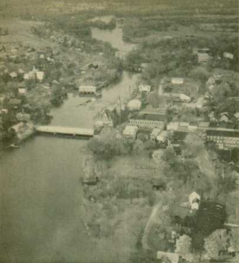
Carleton-Place (Ont.), exemple typique de plusieurs villes de fondation relativement ancienne de l'Est du Canada. Ces villes, qui ont grandi peu à peu, comptent pour la plupart diverses petites industries.
