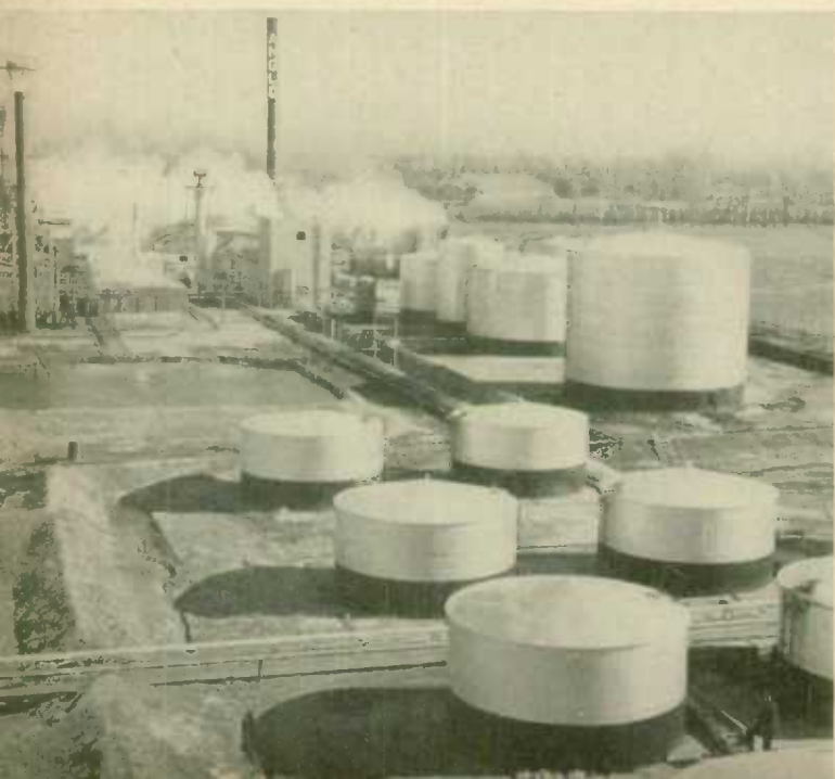
Des raffineries de pétrole ont été construites le long du pipe-line Edmonton-Superior. La raffinerie ci-contre est située à Brandon, principal centre de l'ouest central du Manitoba.
