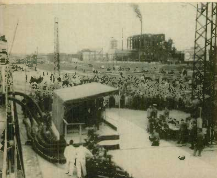
Cérémonie du 24 avril 1951 pour marquer l'arrivée de la première cargaison de pétrole de l'Alberta à la raffinerie de Sarnia (Ont.). Le pétrole brut a franchi en tout une distance de 1,800 milles, des champs à la tête des Grands lacs par pipe-line et le reste par bateau-citerne.
