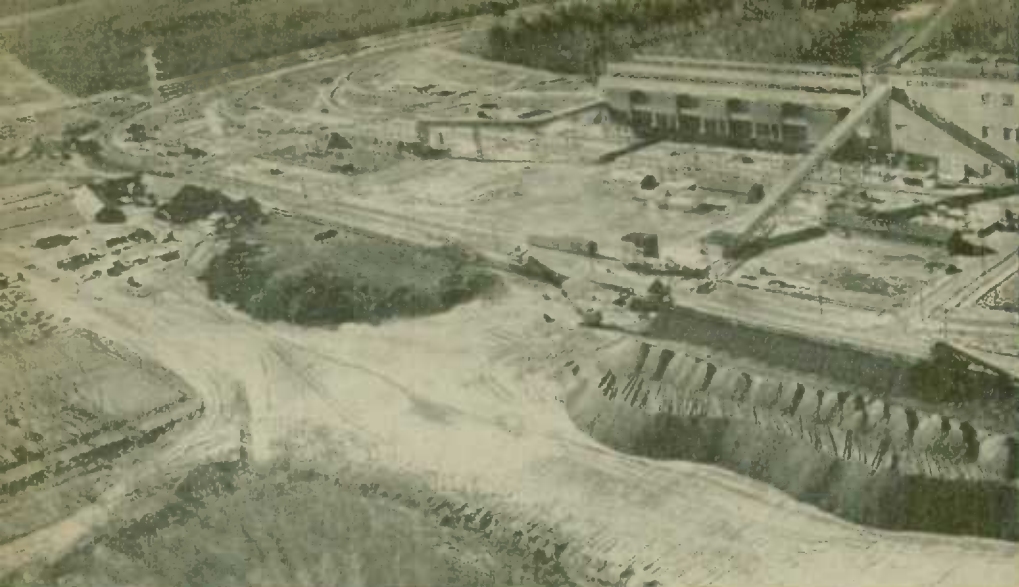
Quai et usine d'affinage en construction à Sorel (P.Q.). La production annuelle de l'usine, qui fonctionnera à plein rendement en 1952, se chiffrera par 200,000 tonnes de fer. L'entreprise comprend des quais de chargement et de déchargement, de même qu'un
