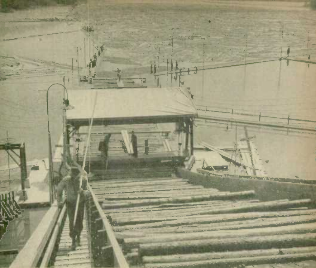
Le monte-charge transporte les billes à l'usine de façonnage, où elles seront coupées en longueurs de 4 pieds en vue de la fabrication de papier.
