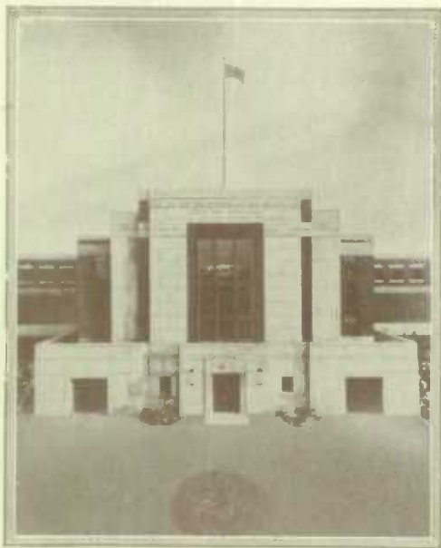
Usine de purification de l'aqueduc d'Ottawa, Ontario.
