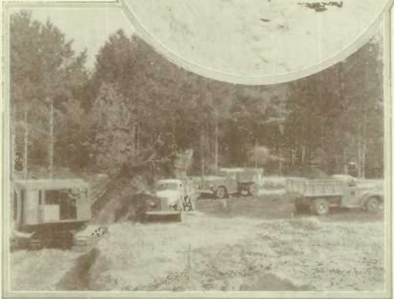
Construction d'une route à travers une forêt dense.
