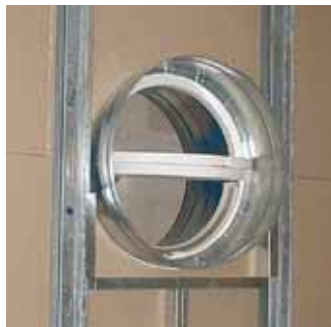
ISONE/Ap en cours de montage
