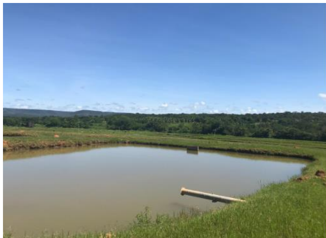
Fig. 11. Área de piscicultura atendida por estudos técnicos de regularização ambiental (Ebenezoete da Luz Souza- Lote 1831- Baraúna)
