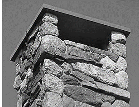
Stone Cap Chimney Top
